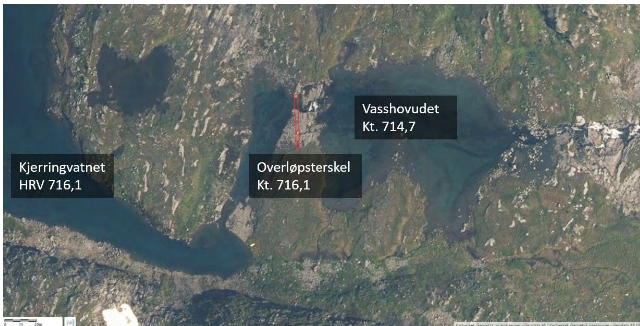
Figur 14 Terskel/sperredam mellom Kjerringvatnet og Vasshovudet.
