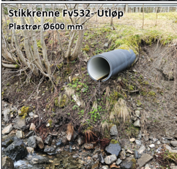
Figur 4-5 Bilder av kulverter og stikkrenner i og ved Svortåa, tatt under befaring 08.04.2025.
