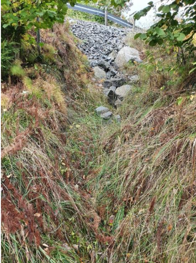
Figur 4-3: Bilde fra bekkefar nordvest for Gjerdane barnehage. Det er observert en liten blotning av løsmasser. Erosjonspotensialet vurderes som lite og det vurderes at det ikke har innvirkning på områdestabiliteten.
