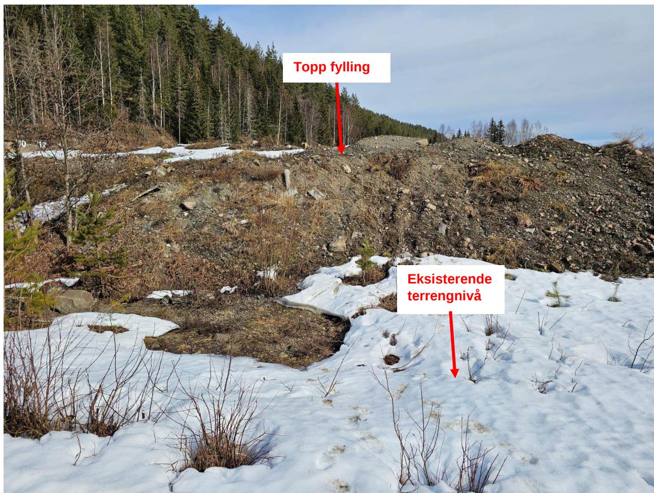
Figur 8: Bilde fra befaringsgjennomføring 2025-03-26. Bildet er tatt fra opprinnelig terrengnivå på vestsiden av fyllingen mot øst/nordøst.
