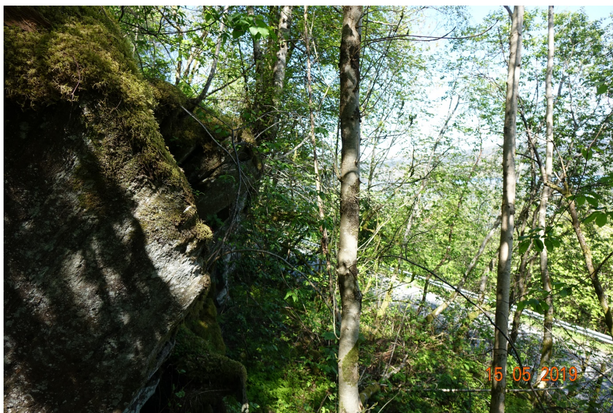
Figur 8: Skrent med avløyste blokker lokalisert ved GPS-punkt 1124.
