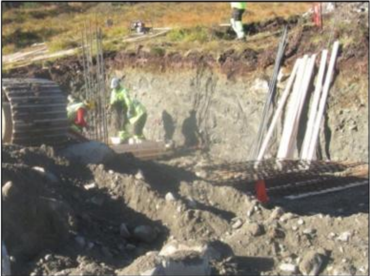
Figur 8: Eksempel mastefundament i løsmasser.
