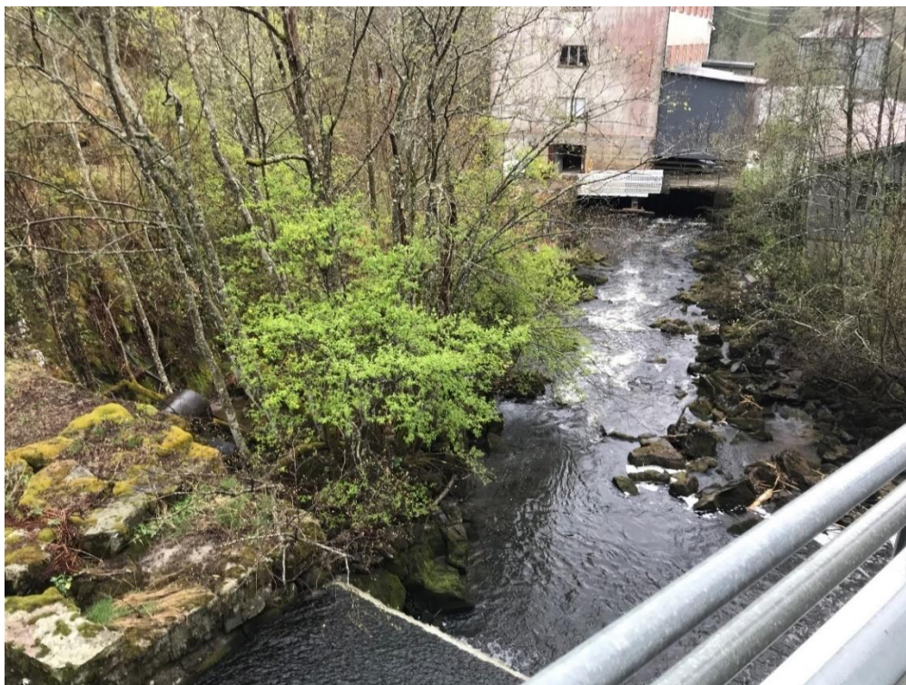
Bilde 6 av synlig del av berørte elvestrekning. Fra dam til Møllebygning. Bilde er tatt i fra fylkesvei.
