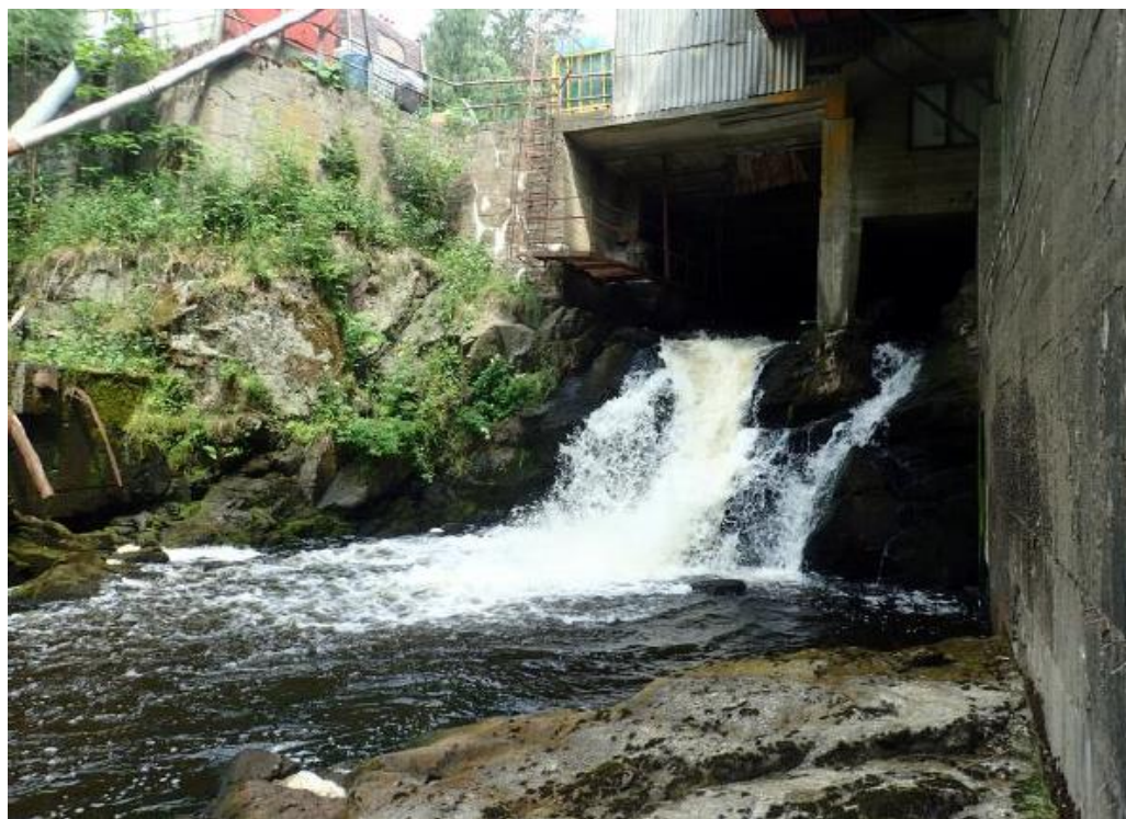
Bilde 3 Viser Brekkefossen som er et naturlig vandringshinder for fiske. Registrert elveperlemusling populasjon er funnet 50m-100m nedstrøms fossen. Bilde viser planlagt avløp fra kraftstasjon.
