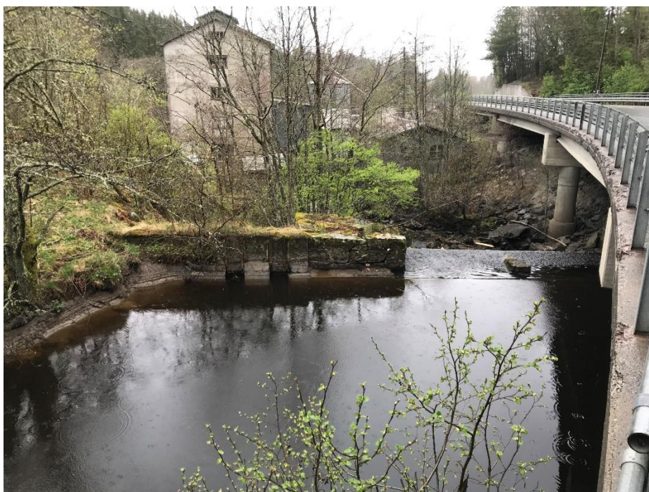
Bilde 1: Eksisterende dam er ca. 2,0-2,5m høy, sett fra inntaksmagasin med to luker.
