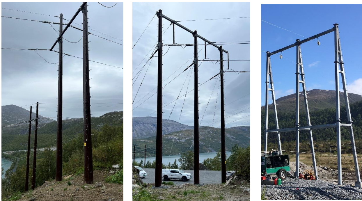
Figur 5-1. Bæremaster i kompositt vil se ut som mastene i venstre bilde, vinkel- og forankringsmaster i kompositt vil se ut som masten i midten. Endemastene ved Fauske transformatorstasjon vil bli som vist på bildet til høyre.
