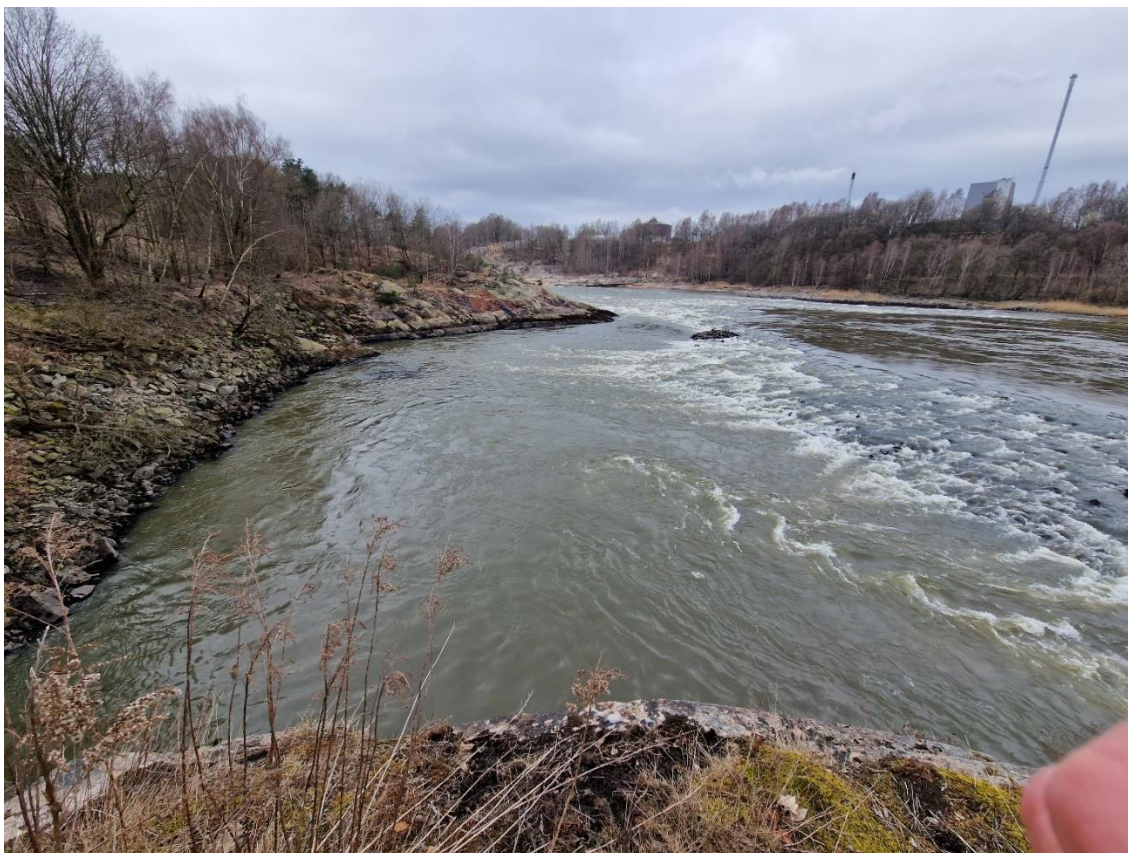
Figur 4-6: Panoramabilde av utløpsområdet, orientert mot vest, over tenkt avløpstunnel. Merk bergneset i bakgrunnen, erosjonsplastring til venstre ved foten av deponiet i bukten og steinmassene i elvebunnen til høyre (terskel).
