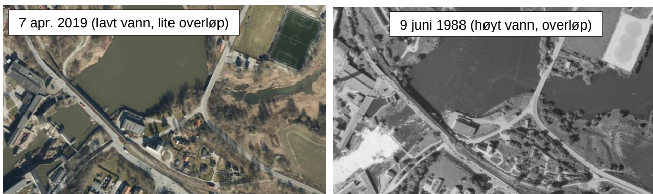
Figur 5-2: Området ved inntakene ved lav og høy vannføring i Glomma. Vannføring og vannstand ved Sarpfoss målestasjon var hhv. 553 m 3 /s og 24,07 moh. (t.v.) og hhv. 1965 m 3 /s og 26,37 moh. (t.h.).
