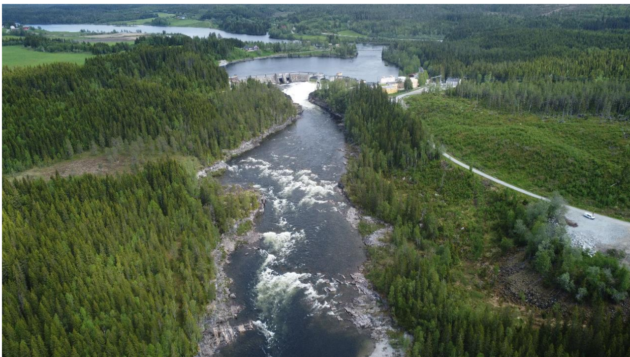
Figur 7. Dronefoto av dagens Aunfoss kraftverk sett fra nedstrøms side ved større slipp over dammen. Gammelt deponi for tunnelmasser kan ses til høyre i bildet, på begge sider av veien mot utslippet. Foto: NTE Energi AS, 12.6.2023.
