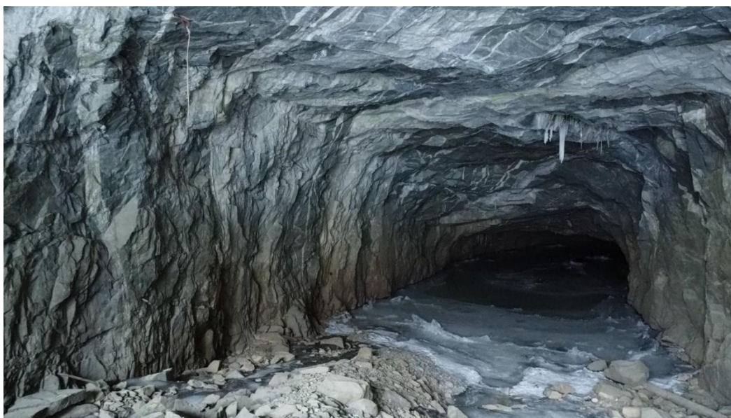
Figur 5. Tverrslaget, omtrent 3 m innenfor påhugget viser bergarten gabbro med folierte lyse og mørke lag i hengen.
