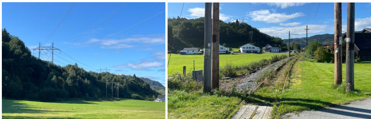
Figur 57 Den nye linjen skal gå i jordkabel fram til tremasten (eksisterende 132 kV) i grensen på dyrka mark i bildet. Videre skal den gå i luftspenn som planlegges mellom eksisterende 132 kV linje og 420 kV linjen høyere oppe i terrenget. Foto: Guro Skjelstad, Asplan Viak AS
