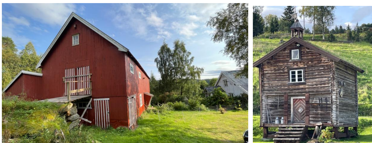
Figur 49 Venstre: Driftsbygning i Solemsli. Høyre: Stabburet på Solem står i dag, men de øvrige bygningene i tunet er erstattet av nye bygg. Foto: Guro Skjelstad, Asplan Viak AS
