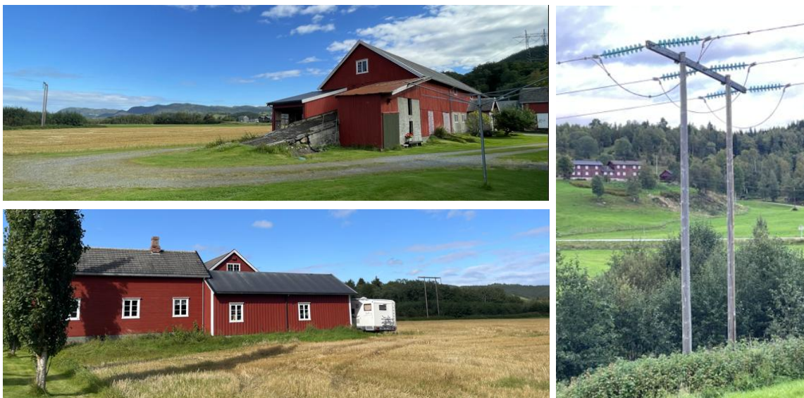
Figur 28. Mastetypen som Tensio TS har søkt om utsatt frist til å rive og som er listeført som et teknisk-industrielt kulturminne er vist på bildet til høyre. Bildene til venstre er tatt mot nordøst, fra det østligste tunet på Ekli innenfor KM 1. Mastene ses bak i bildene. Foto: Guro Skjelstad, Asplan Viak AS.
