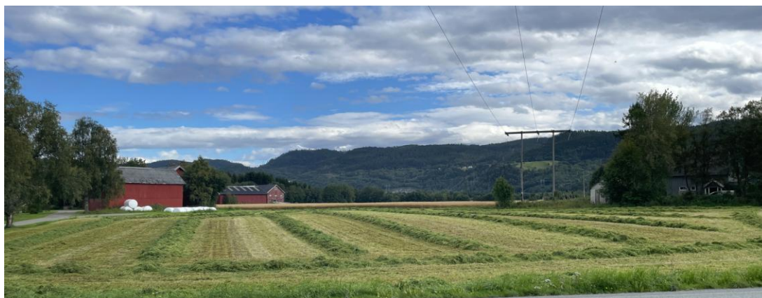
Figur 59 Den nye kraftlinjen vil bli lagt i noe større avstand fra tunet på Bakkmoen enn eksisterende linje. De nye stålmastene vil bli høyere (20-30 meter) og ha et industrielt uttrykk. Foto: Guro Skjelstad Asplan Viak AS
