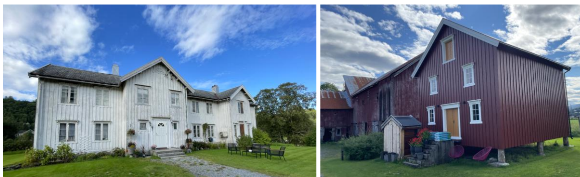
Figur 33 Tunet på Ødyn (gnr. 194, bnr. 4) framstår som særlig intakt, og med stor aldersverdi (våningshus fra 1700-tallet). Stabburet er nylig restaurert, mens andre bygninger i tunet trenger vedlikehold. Foto: Guro Skjelstad, Asplan Viak AS
