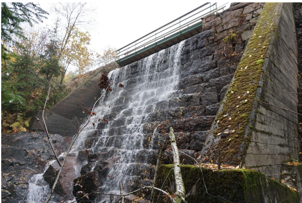
Bilde 1. Kudalsdammen sett fra nedstrøms side
