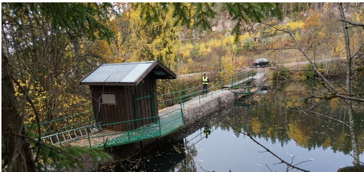
Figur 3. Dam Kudalsdammen sett fra oppstrøms side mot vest hvor Suluvannsveien passerer.
