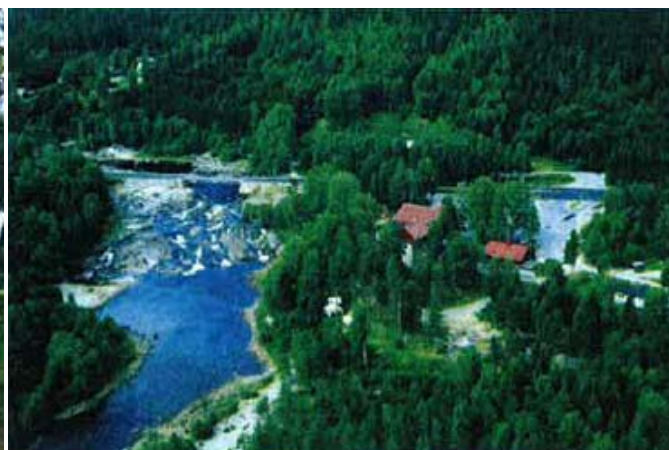
Figur 7-36 Fossen Kro & Motell til høyre. E134 krysser elva over brua. Bilde: Skagerak Kraft
