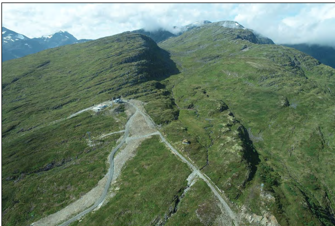
Figur 4-1: Dronefoto som viser eksisterende inngrep ved planlagt anleggsområde. Foto: Strandafjellet skisenter.
