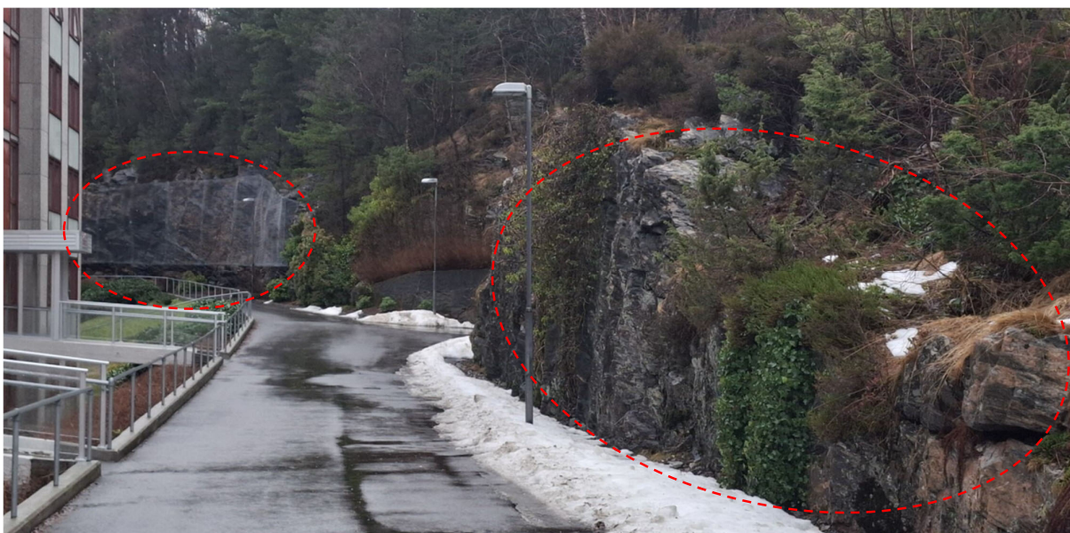
Figur 8: Bergskjæringer ved Sandgotna borettslag uten signifikante løsmasseavsetninger ved topp bergskjæring. Lokalteten ligger innenfor aktsomhetsområde for kvikkleireskred.
