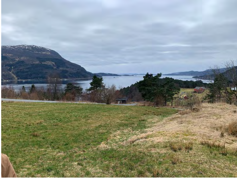
Rørgaten fortsetter nedover, nedgravd i innmarken og krysser en grusvei ved furuene på bildet.
