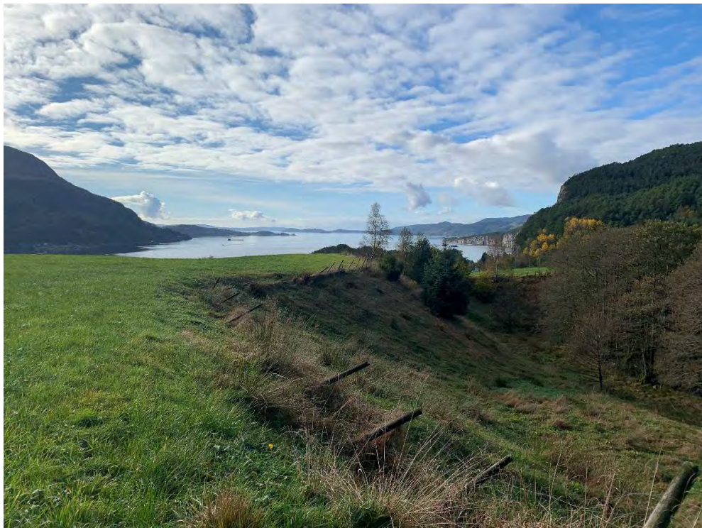
Bildet tatt like etter broen på innmarken der trykkrøret graves ned. Elven sees i morenemassene nede til høyre.
