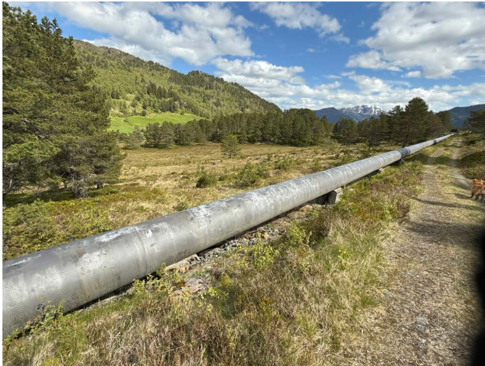
Figur 4. Dagens røyrledning ligg oppe på terrenget. Langs det meste av røynet går ein anleggsveg som blir brukt til vedlikehald. Områda rundt dagens røyrledning består av vekslande myrområder og furuskog på fastmark.
