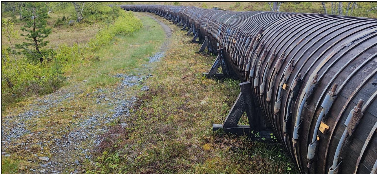
Figur 3-22: Eksisterende rørgate. Bildet tatt på befaringsmai 2025.
