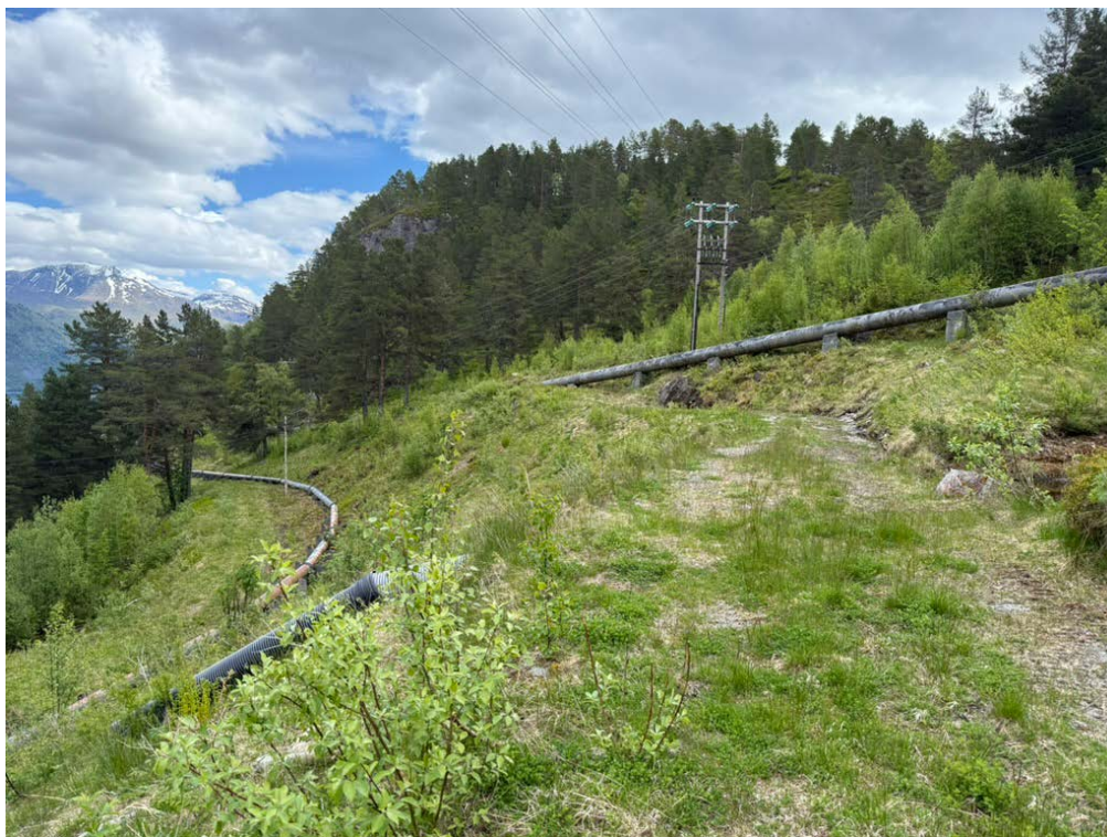
Figur 5. Siste del av traseen er å rekne som sterkt endra mark. I tillegg til røyet frå Nysetervatnet, ligg og røyet frå Brunedammen i dette området, samt ei kraftledning og anleggsveggar.
