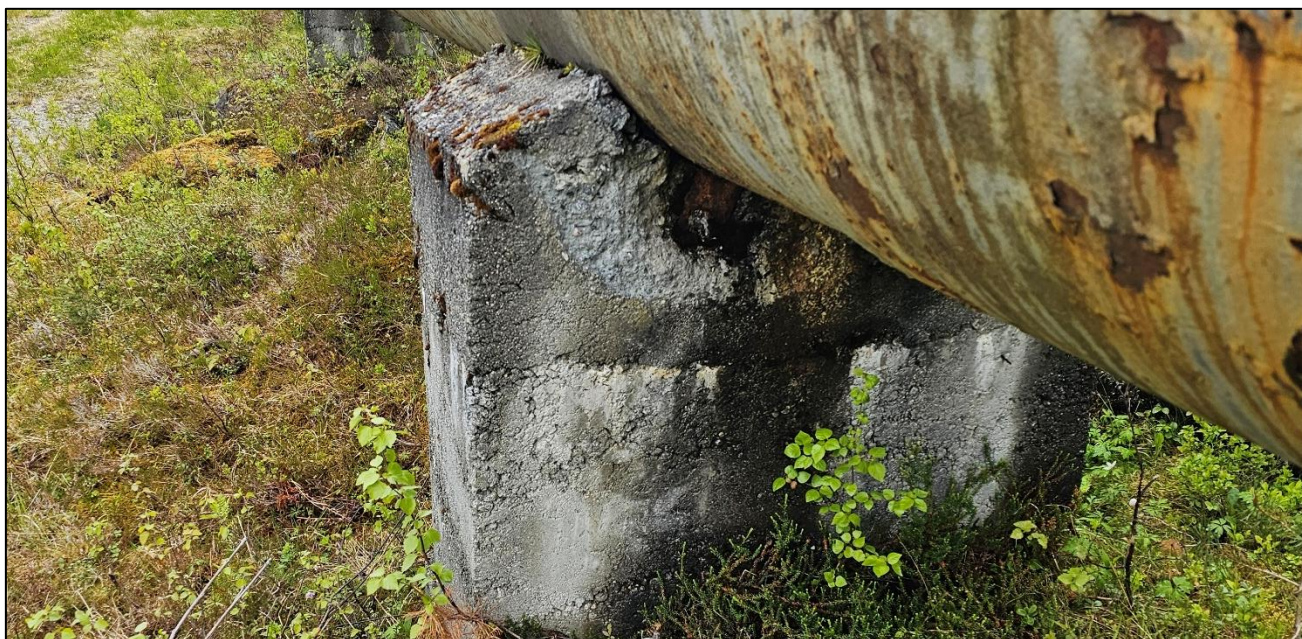
Figur 3-23: Eksisterende betongfundament. Bildet tatt på befaringsmai 2025.
