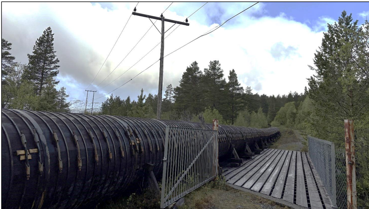
Figur 3-27: Dagens bru. Bildet tatt på befaring mai 2025.
