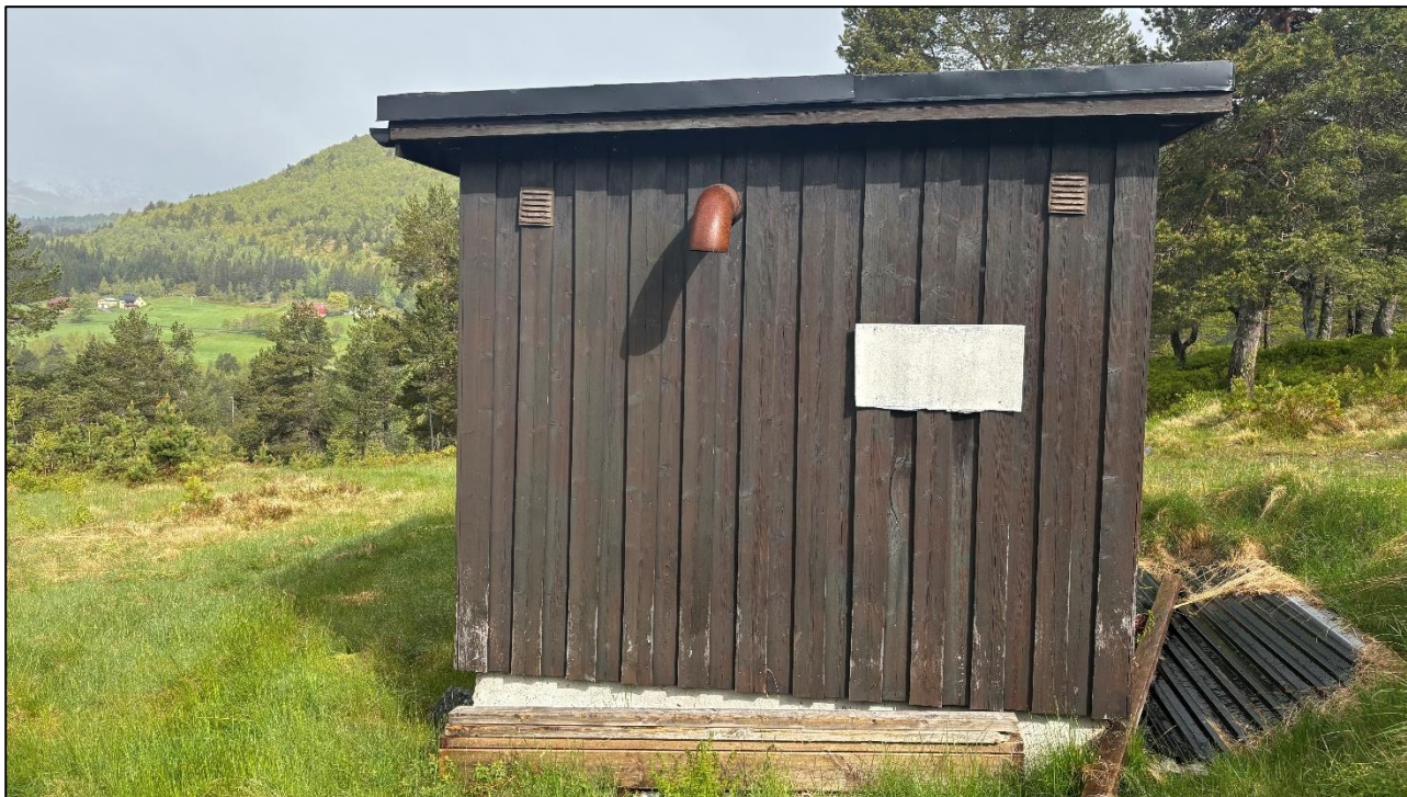
Figur 3-26: Eksisterende ventilhus. Bildet tatt på befaring mai 2025.
