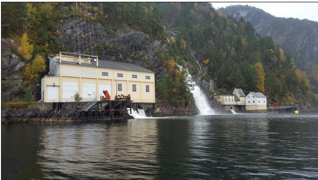
Figur 1-1: Fausa kraftverk sett fra Storfjorden.
