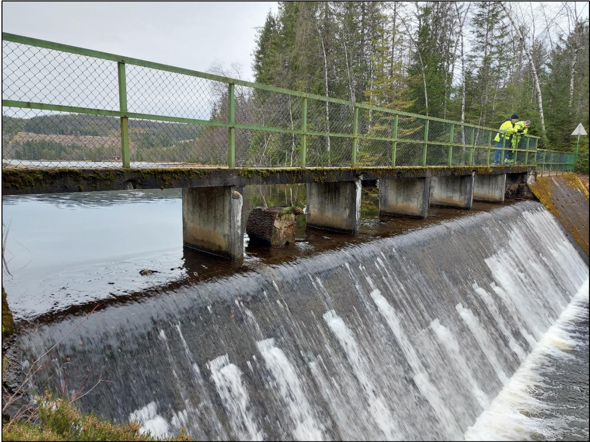
Figur 1. Dammen ved Garsjø som skal rehabiliteres.
