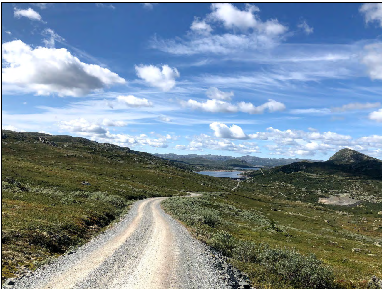
Figur 2-1: Grottedammen sett fra øst. Grottetippen sees til høyre i bildet. Foto: Norconsult AS.
