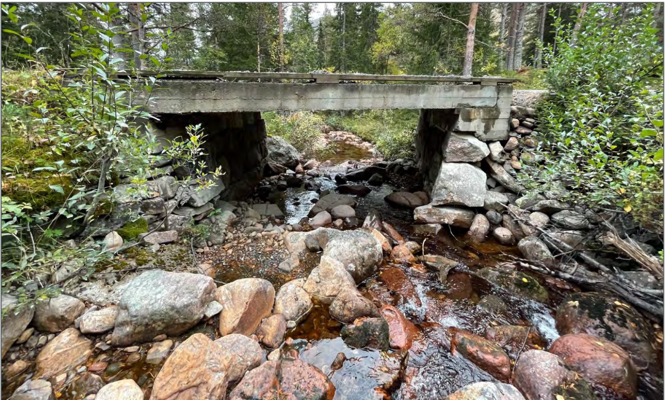
Figur 2-16: Storbekk bru sett nedover bekken. Foto: Statkraft.
