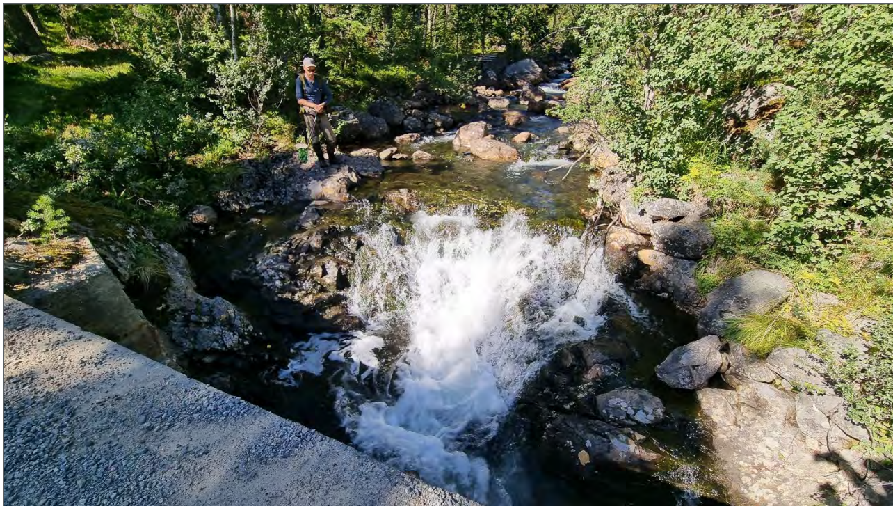
Figur 2-18: Foss oppstrøms brua i Ramsåe. Foto: Norconsult AS.
