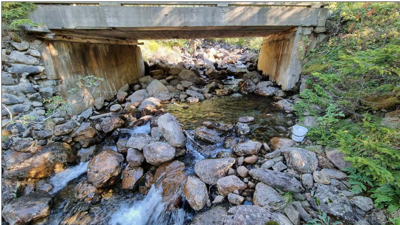
Figur 2-14: Gjuvsbekken bru. Naturlig bekkesubstrat. Bredde lysåpning under bru er ca. 5 meter. Merk noe oppstuvning av større stein på venstre side i bekkeløpet like oppstrøms brua/inn mot brufundament. Foto: Norconsult AS.
