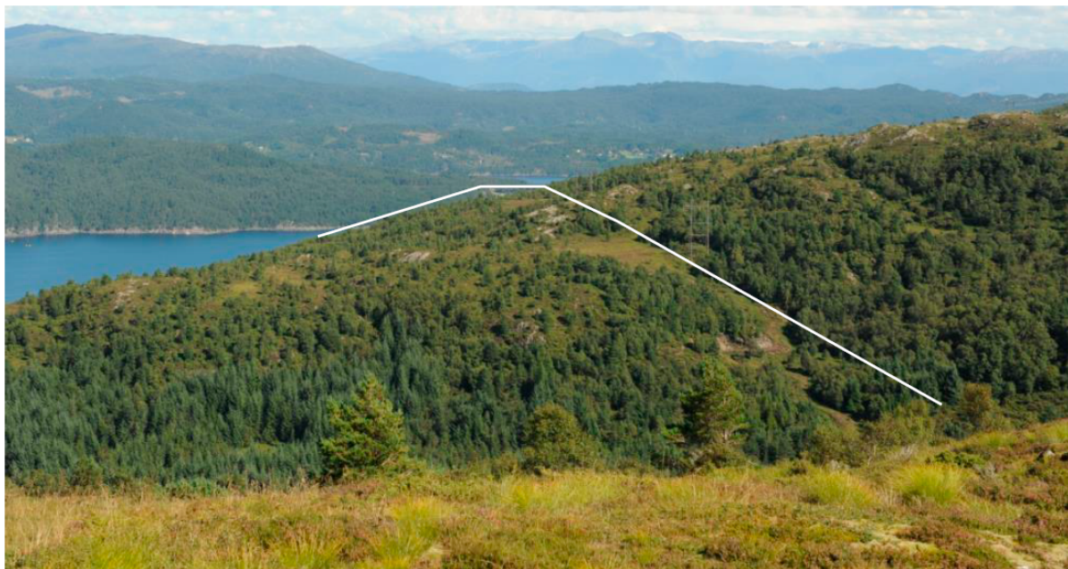
Figur 17. Ny 132 kV ledning følger eksisterende 300 kV ledning et stykke før knekkepunkt ned mot Grønestølen. Ny ledning vil bli litt lavere og ha en annen mastetype enn dagens ledning. Kilde: Fagnes konsesjonssøknad
