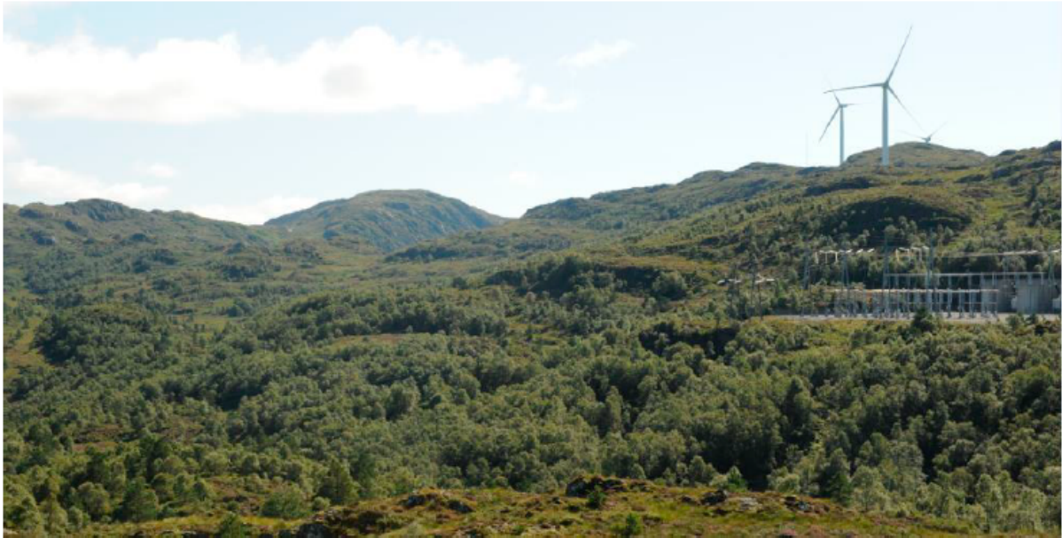
Figur 16. Fra Midtfjellet transformatorstasjon til høyre i bildet vil kraftledningen gå parallelt med eksisterende 300 kV-ledning. Det er vanskelig å se dagens ledning i bildet som skyldes at det blant annet ikke er et tydelig ryddebelte. Kilde: Fagnes konsesjonssøknad
