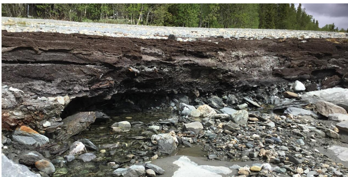
Figur 2-15 Bekken har gravd seg ned til grovere masser/fjell, men det er noe erosjon i gammelt torvlag.
