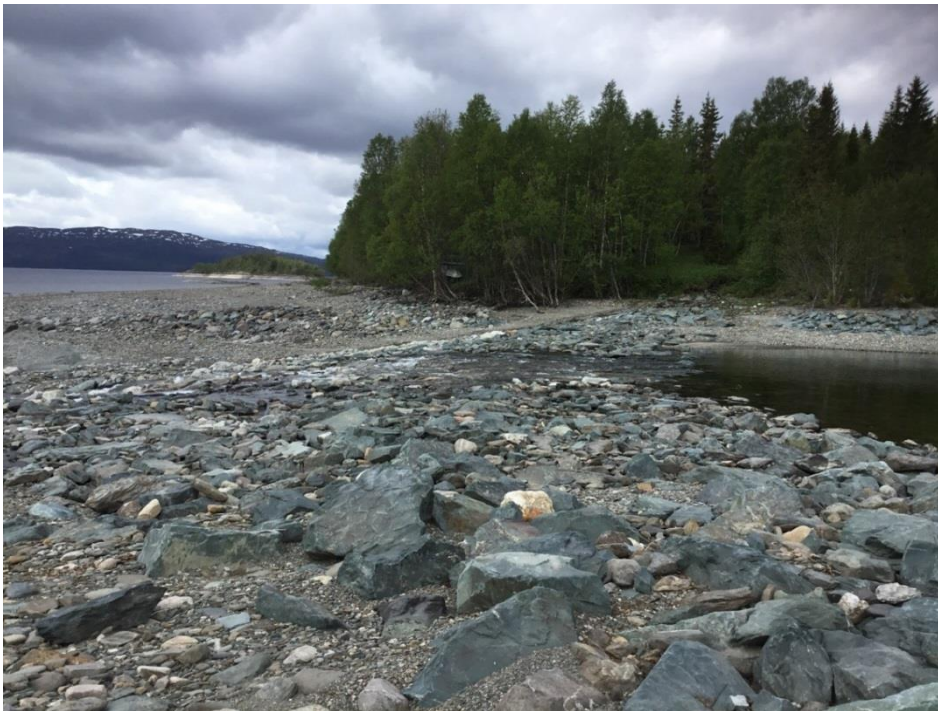
Figur 2-13 Her er det bygd en terskel for å danne et vannspeil oppstrøms.
