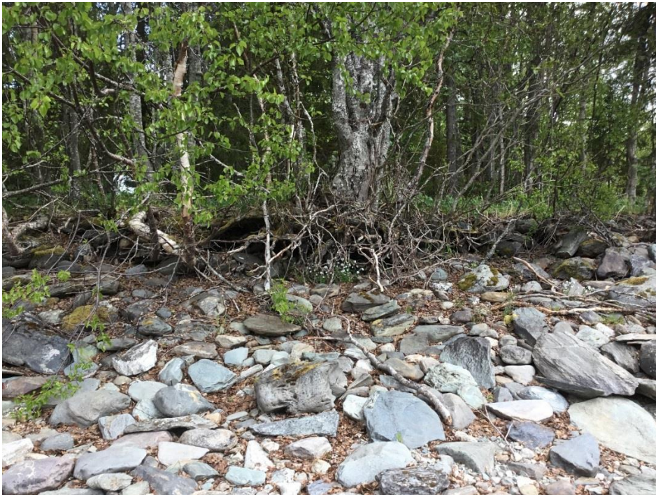
Figur 2-14 Noe utvasking som ser ut til å ha stabilisert seg.
