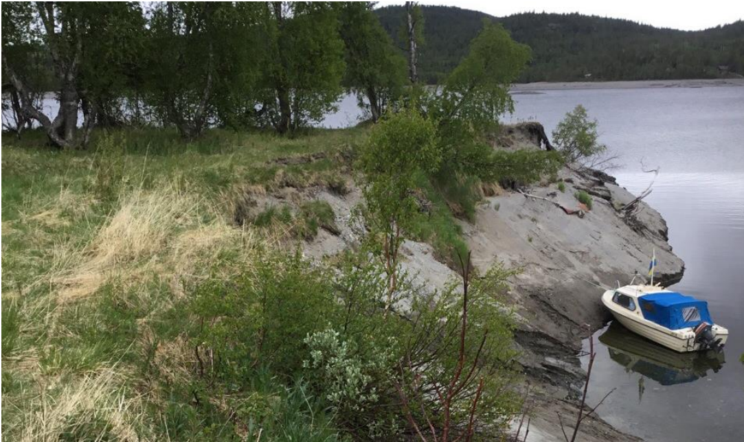
Figur 2-5 Erosjon ved Fjellvang. Traktorvei går langs raskanten. Foto: OKB
