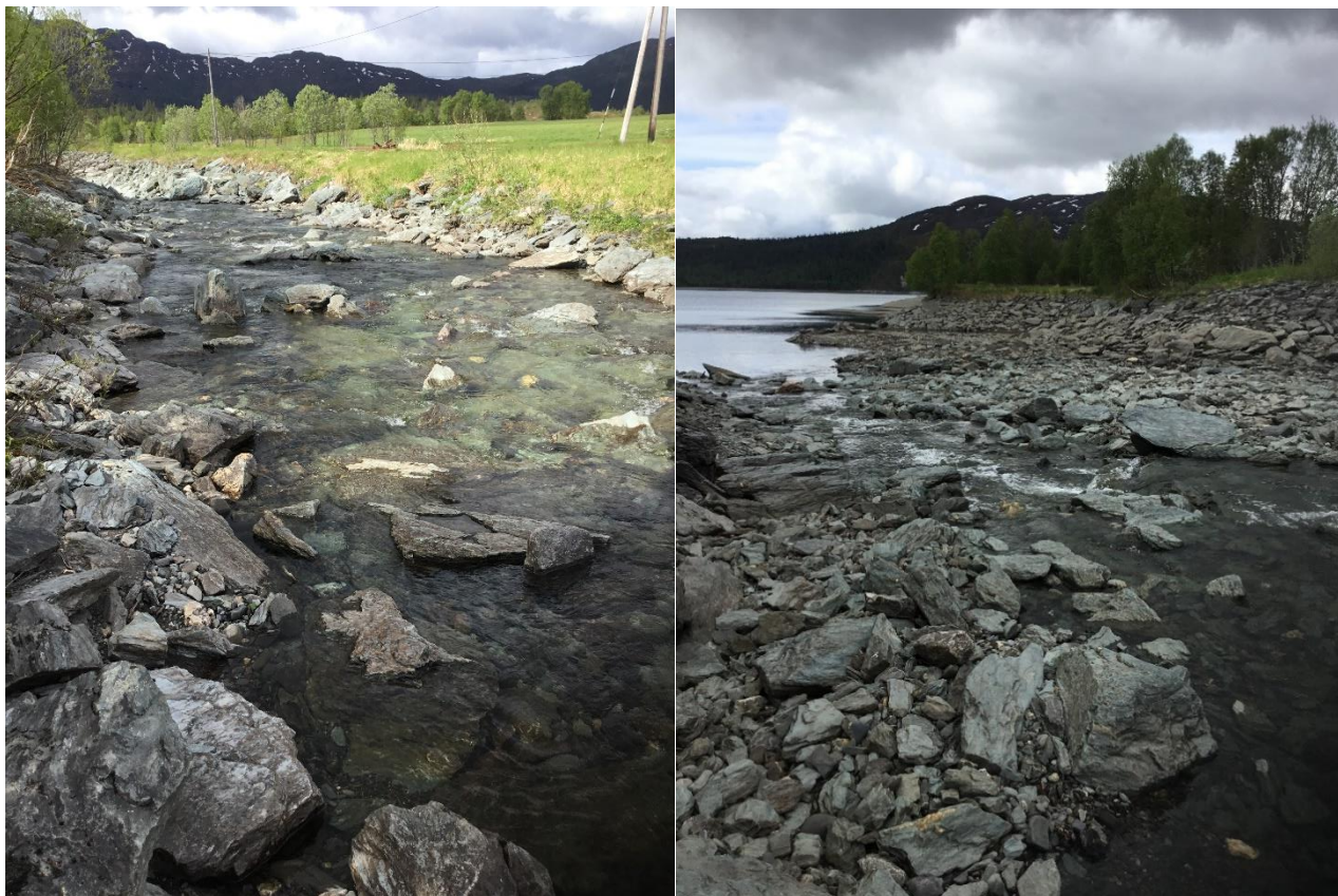
Figur 2-7 Sikring i Limingelva, mot områder med dyrka mark.
