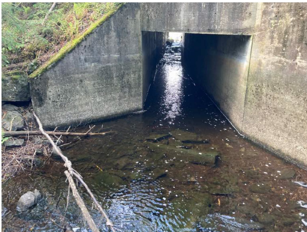
Figur 20 Kulvert under fv 47 sett nedenfra
