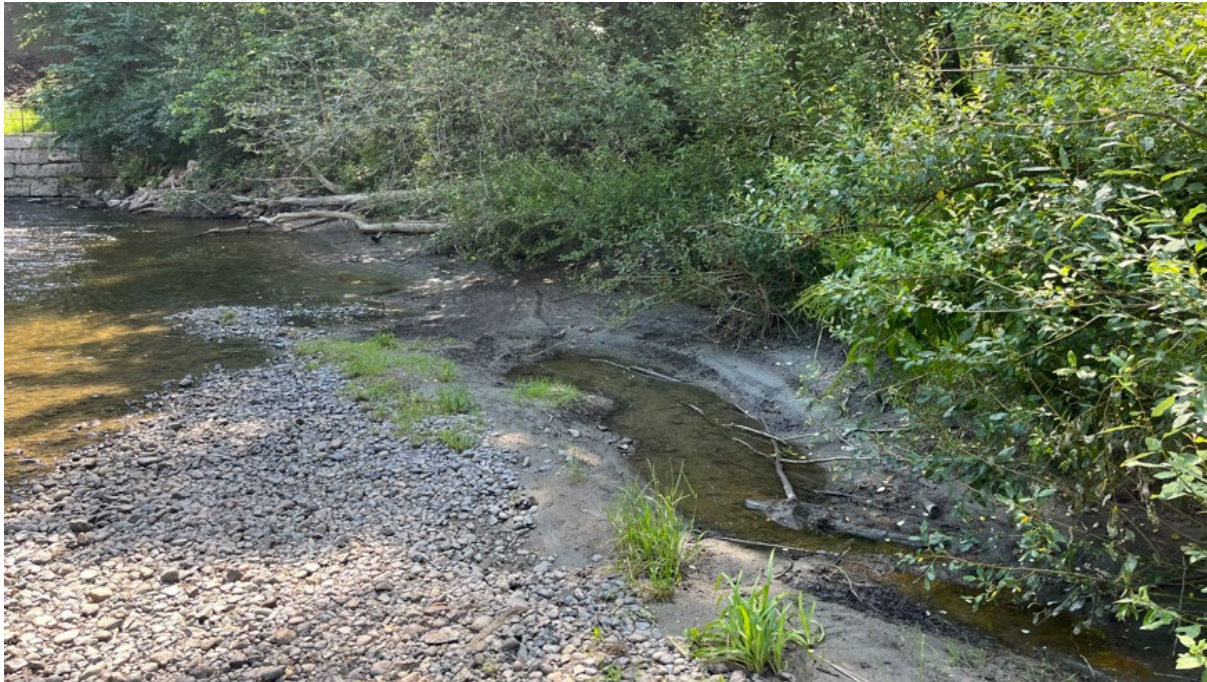
Figur 3.9 Bilde av dagens tilstand langs vestbredden av elva, oppstrøms brua på Ringeriksveien.
