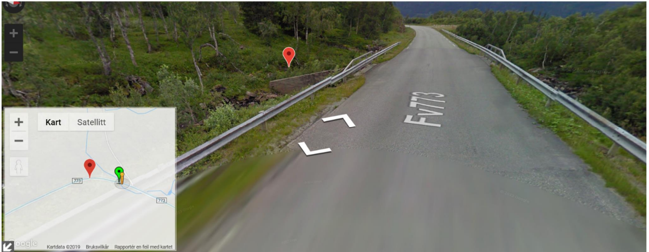
Fig. 2c Bilde av bru av nedre sponsbekkbrua
