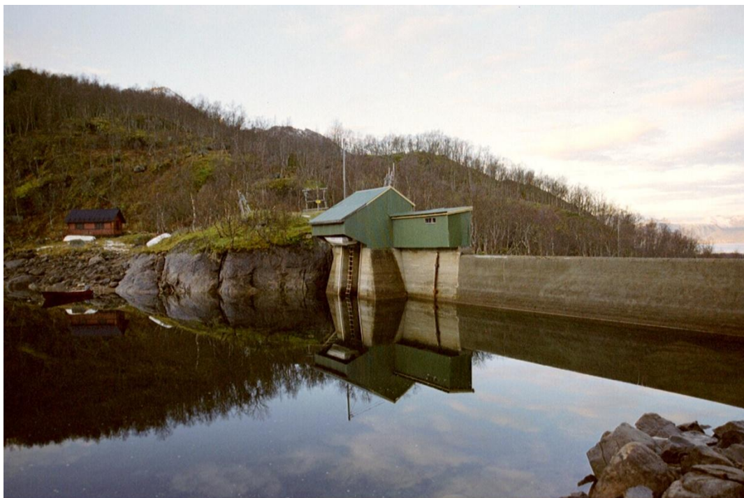
Figur 2. Mellomvatn inntaksdam sett fra oppstrøms side [7].
