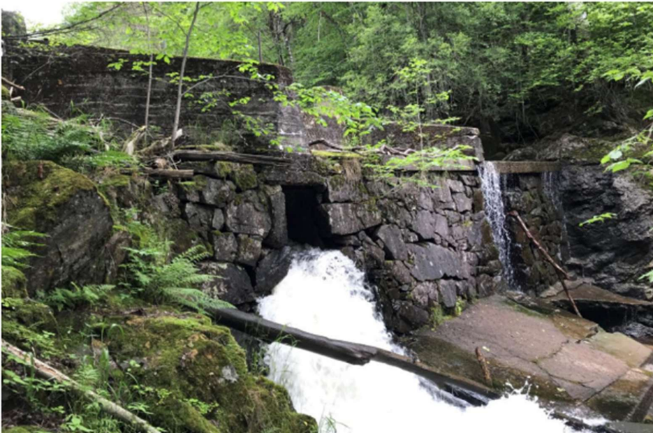
Figur 3.1: Bjørumdammen sett fra nedstrøms side (1).
