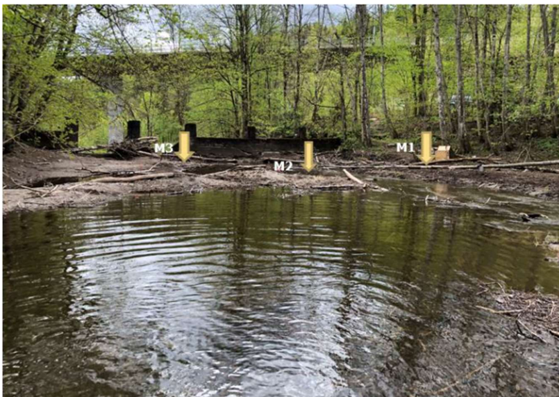
Figur 4.5: Bilde fra feltarbeid 18.05.2020. Demning sett fra nord (12).
