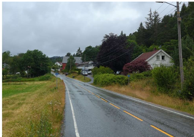
Figur 5-2. Bygningstilstand langs Loneveien.
