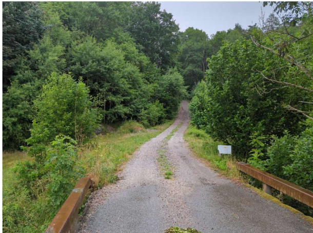
Figur 5-23. Postveg som kjøreveg (id 177600) bygget i 1807 og i allmenn bruk til 1928.
