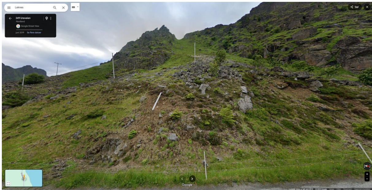
Figur 9: Avsetninger helt sør i påvirknings- og kartleggingsområdet. Mindre blokker og avsetninger i form av grus vitner om avsetninger relatert til snøskred, mens avsetninger noe mer mot nord er mer blokkrikt og viser til steinsprangavsetninger (ur).
