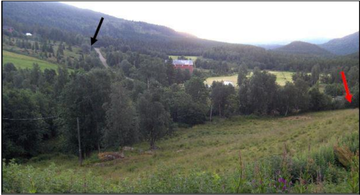
Figur 20: Bildet viser sannsynlig påkoblingspunkt til 22kV-linje (svart pil). Kraftstasjon bygges ved bro i høyre bildekant (rød pil).
