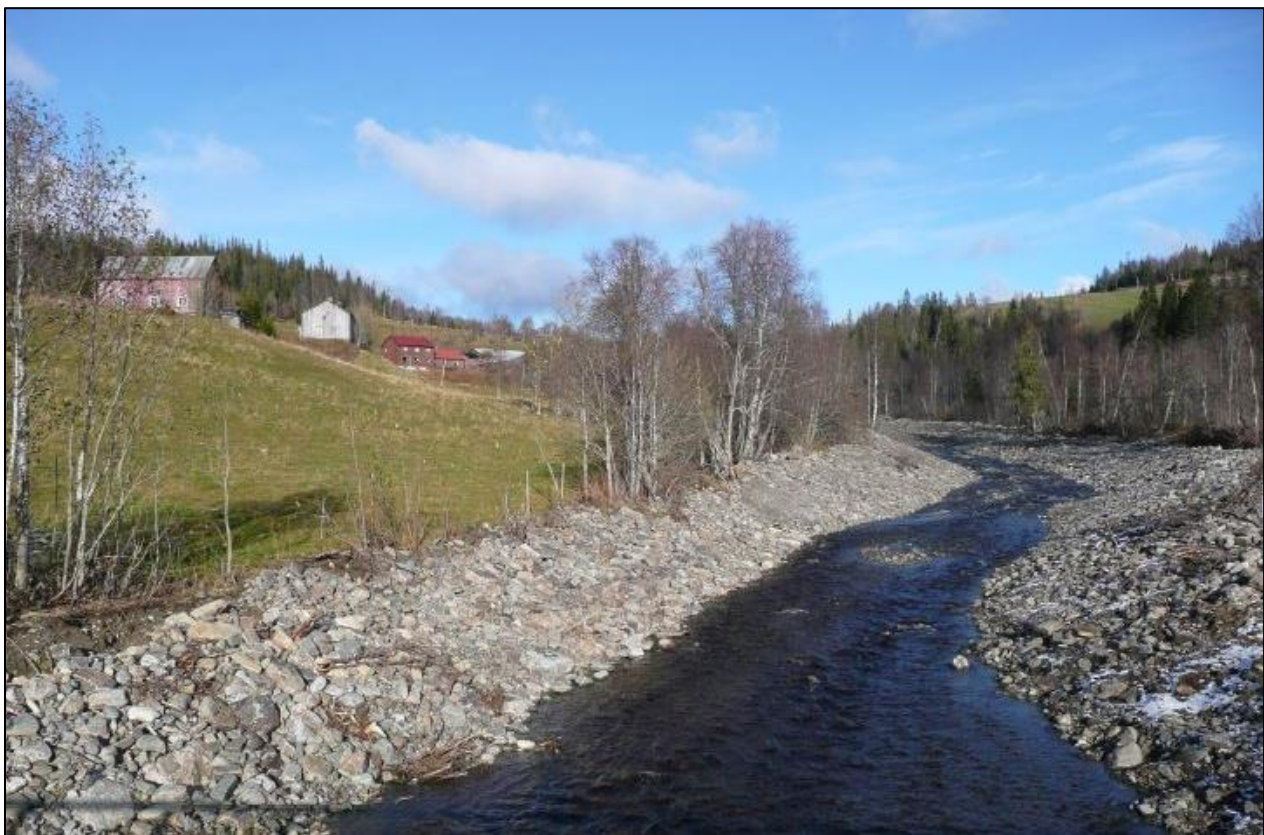
Figur 33: Bildet viser utført sikring av elveløpet oppstrøms kote 410. Kraftstasjon plasseres i venstre bildekant.
