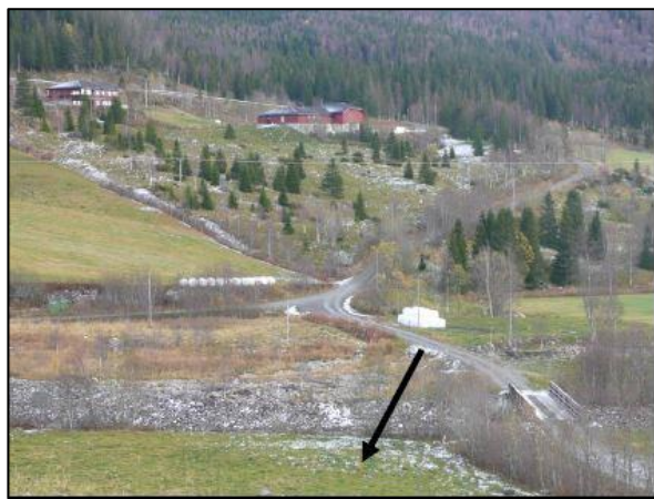
Figur 18: Kraftstasjonen plassering vist med pil.
