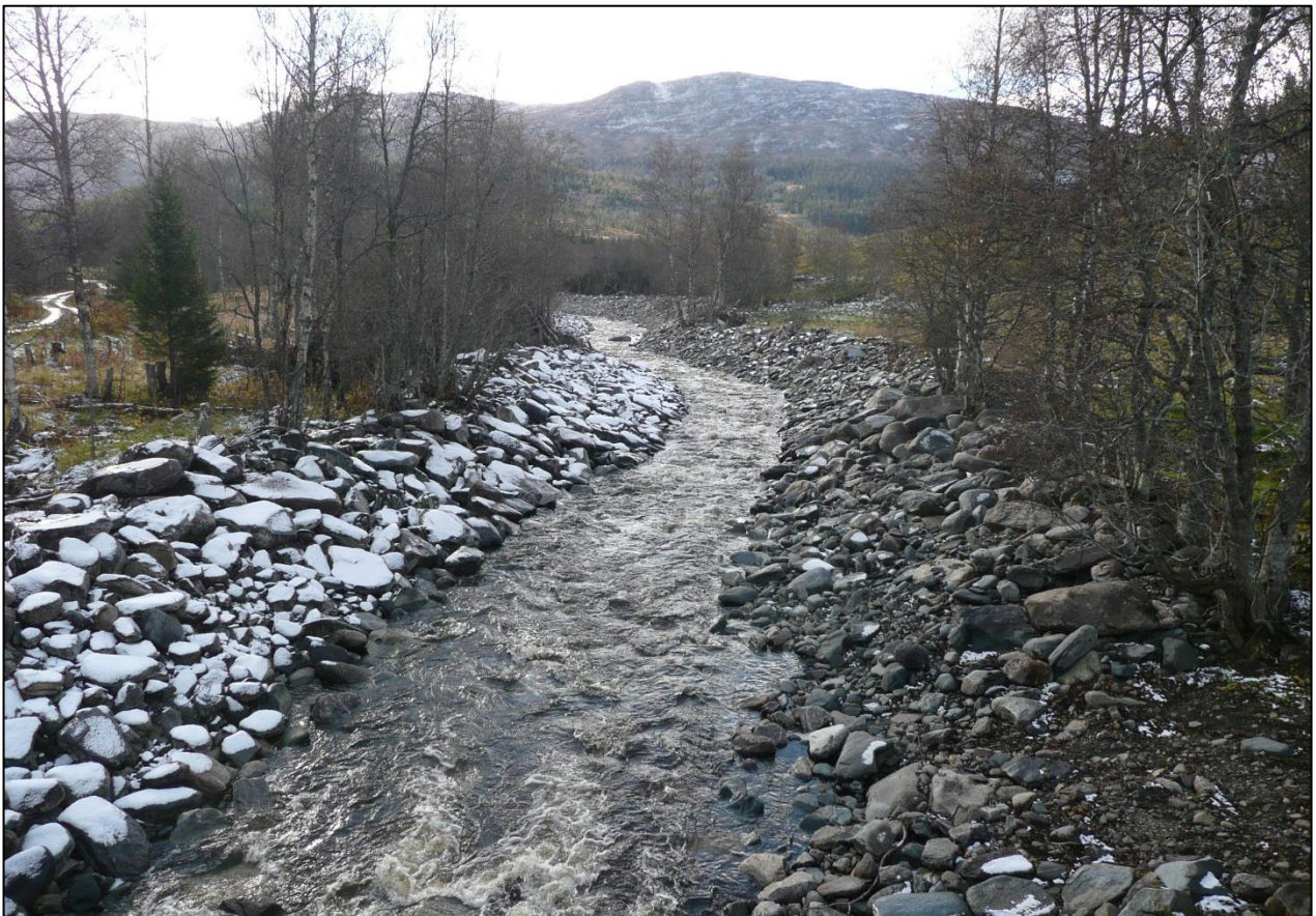
Figur 32: Bildet viser Aunelva nedstrøms Aunbrua etter utført sikring av elveløpet i forbindelse med flom sommeren 2010.
