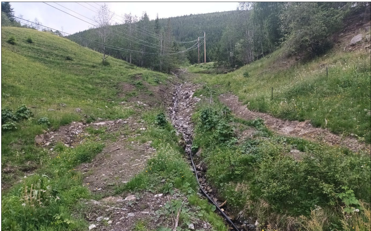
Figur 10: Dreneringspunktet i midtre del av kartlagt område er hovudsakleg utarbeida for å styre dreneringa som kjem ned frå fjellsida. Dei eksponerte lausmassane indikerer at avrenning frå fjellsida vil konsentrere seg her, og det kan førekomme erosjon og utglidingar langs dreneringsvegen. Infopunkt 2.
