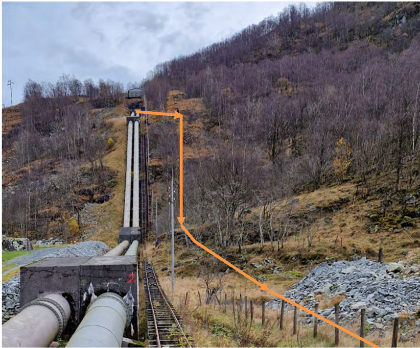
Bilde 1: Ny vassveg røyr i grøft.
