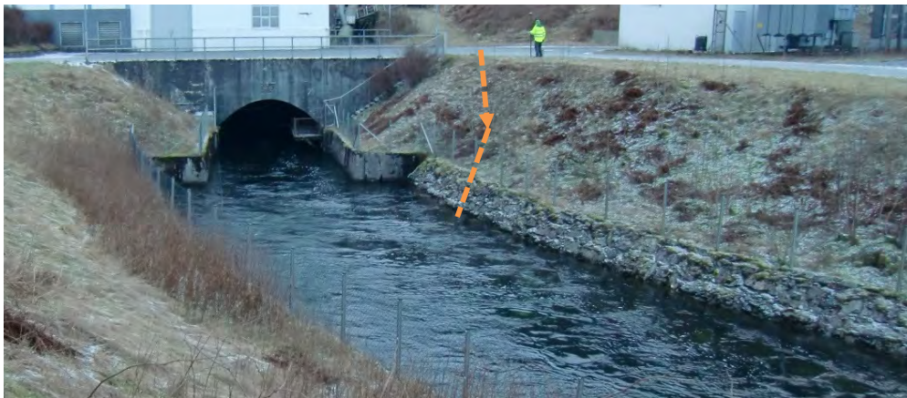
Bilde 3: Ny utløpskanal frå ny stasjon, eksisterande utløpskanal til venstre i bildet
