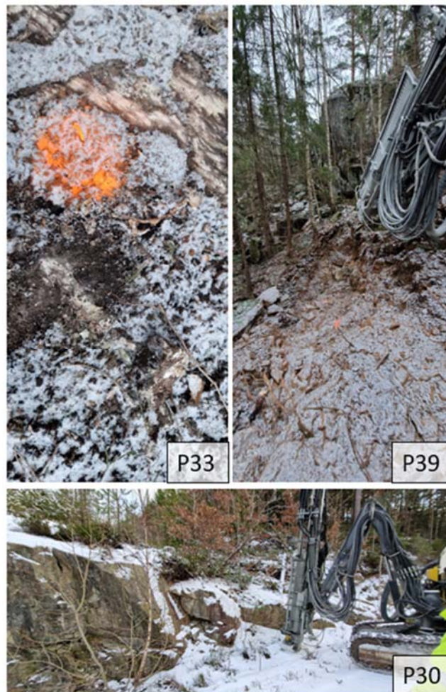
Figur 6: Bilder fra feltarbeid 29.11-30.11.2023 som viser ulike farge og mekanisk styrke ved prøvepunkt P30, P33 og P39. Plasseringen til punktene er vist på 10227602-RIGm-TEG-001.
