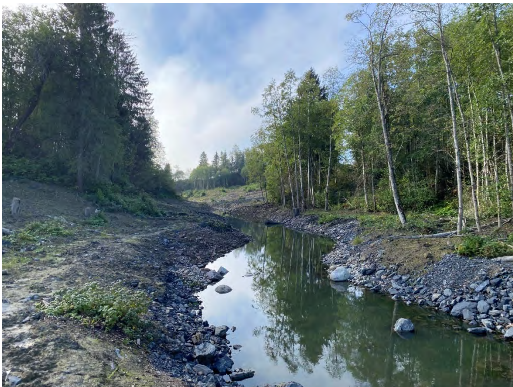
Figur 31: Bildet tatt fra ca. P550 og nedover bekken. Oppdemmet bekk pga. ekstra hevet bunn ved skred høyre side på strekning P650-P700.
