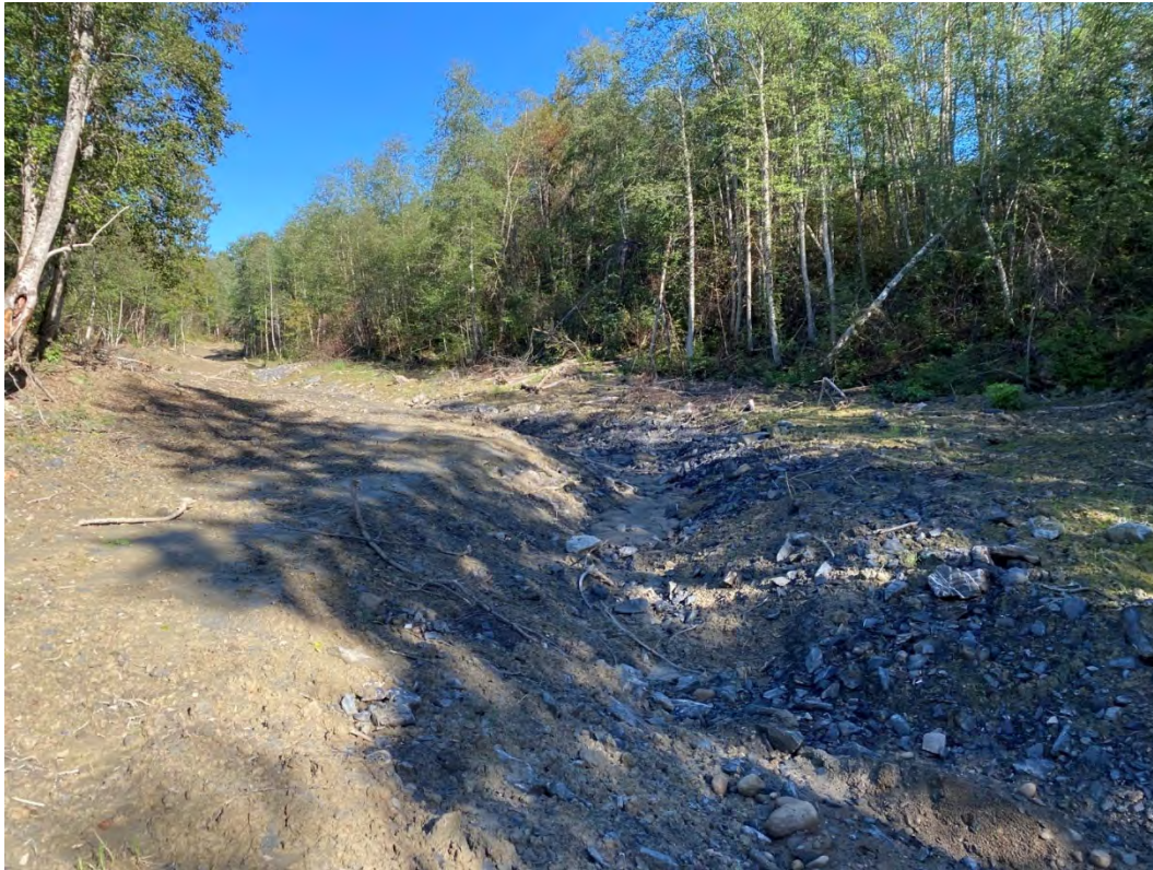
Figur 60: Bildet tatt fra ca. P570 og oppover bekken
