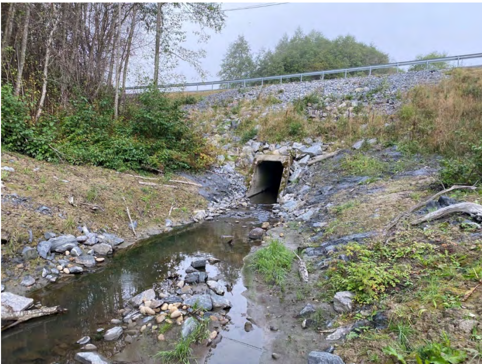
Figur 13: Øvre ende av Leirbekken, P0 ved utløpet av kulvert under Nannestadvegen
