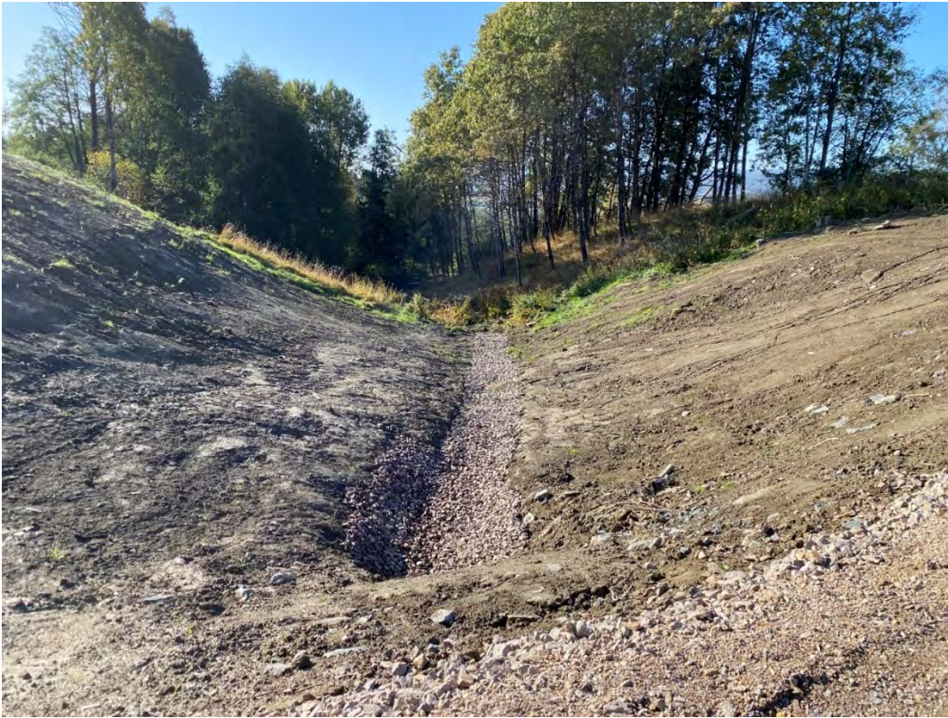
Figur 91: Ravine ved Senepsrud gård sikret og drenerende masser og rør er lagt for å håndtere overvann.
