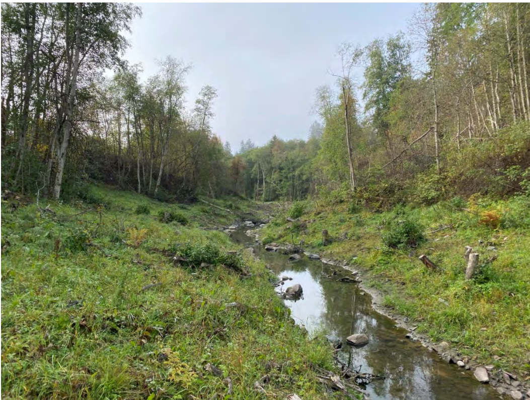
Figur 17: Bildet tatt fra ca. P200 og nedover bekken. Ferdig lagt april - rask vegetering fra april til september
