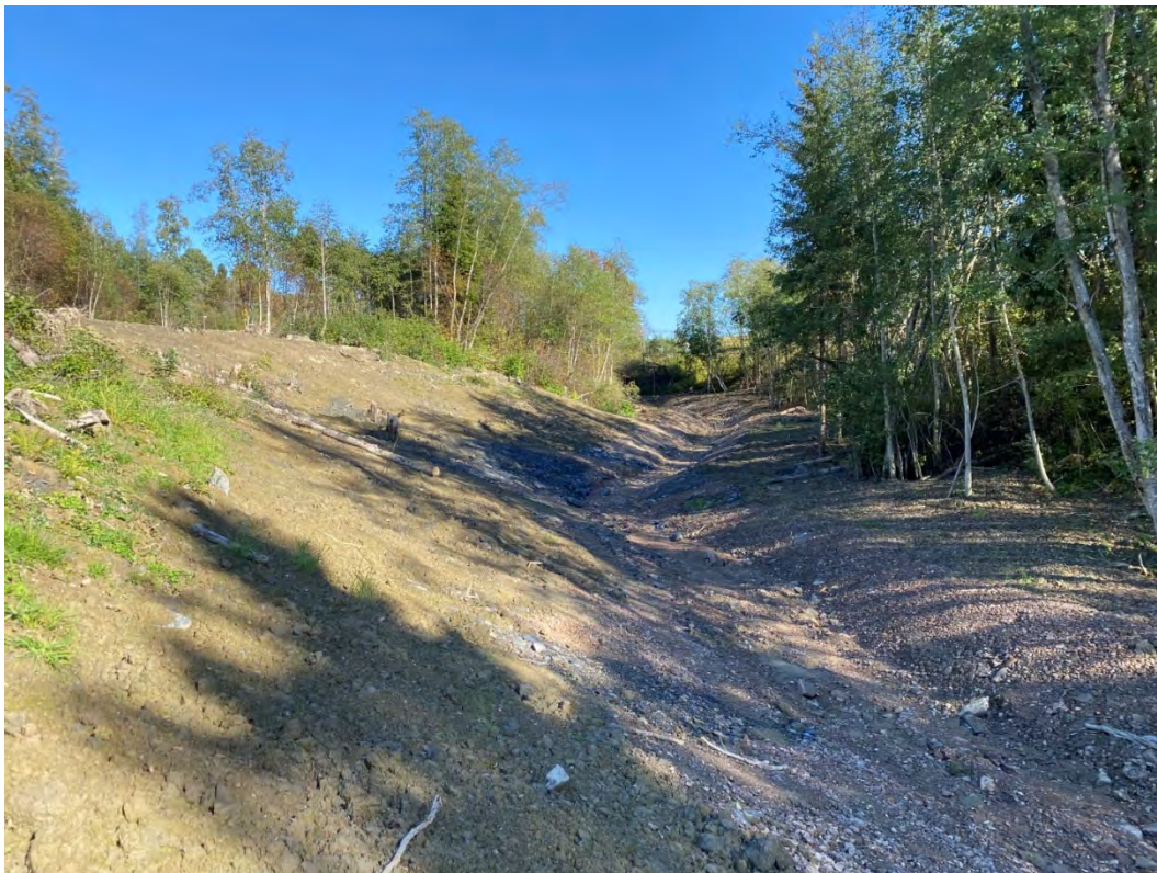
Figur 71: Bildet tatt fra ca. P90 og oppover bekken. Høyre side av bekken støttefylling bestående av masser fra avlastinger.
