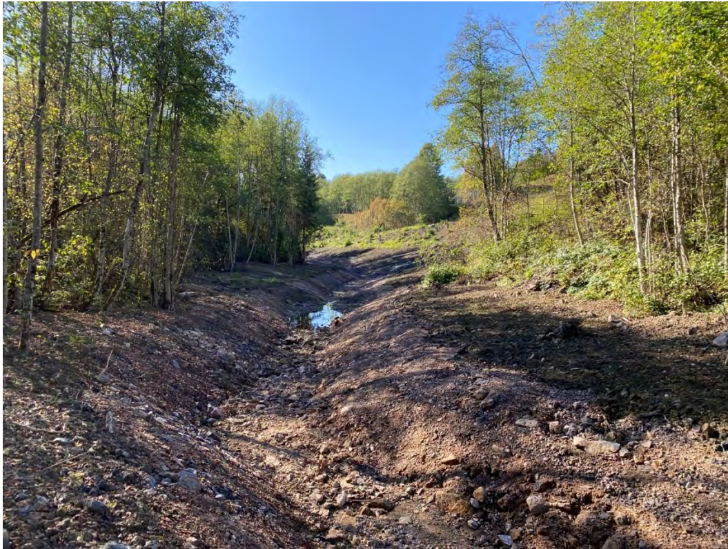
Figur 74: Bildet tatt fra ca. P50 og nedover bekken
