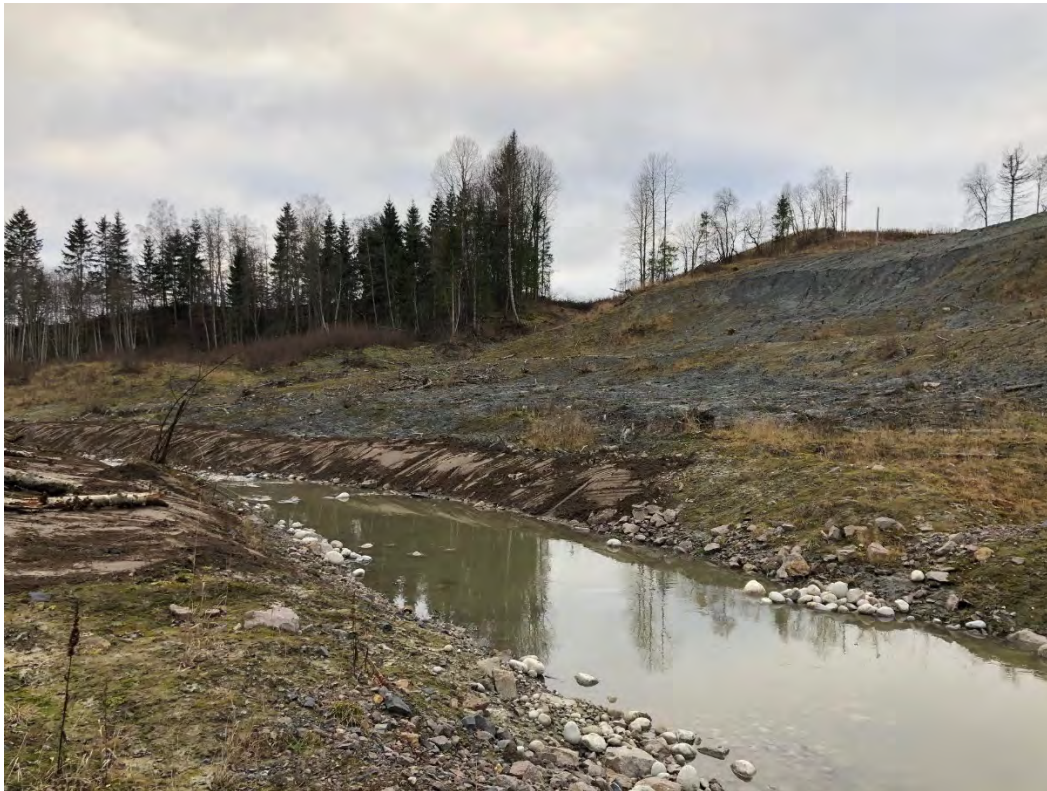
Figur 34: Bilde 17.11.2022. Bildet er tatt fra ca. P600 og nedover bekken. Viser skred høyre side stabilisert og avlastet skredkant. Øvre ende miljøtiltak ved P620
