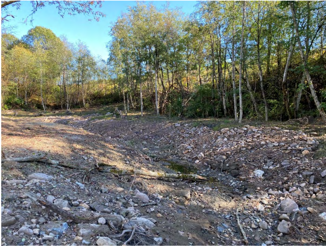
Figur 66: Bildet tatt fra ca. P250 og oppover bekken
