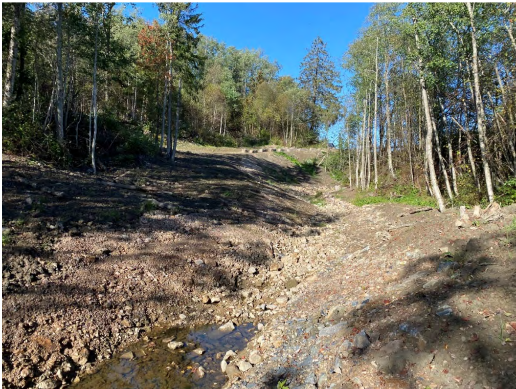
Figur 75: Bildet tatt fra ca. P50 og oppover bekken
