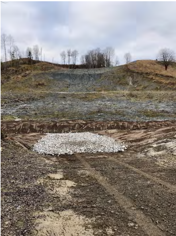
Figur 33: Bilde 17.11.2022. Anleggsvei fra øst ned til Leirbekken ved P650. Miljøtilpasset nedre del og med et pukklag for å håndtere overflatevann.
