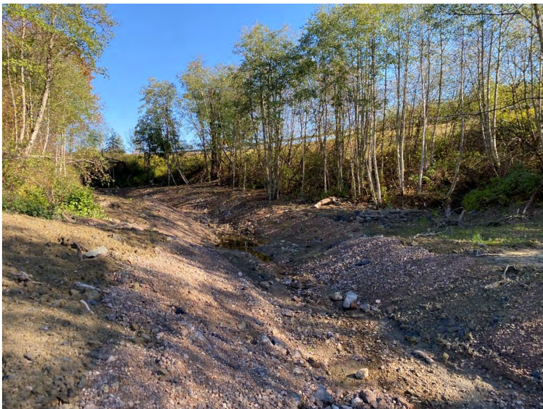
Figur 73: Bildet tatt fra ca. P75 og oppover bekken
