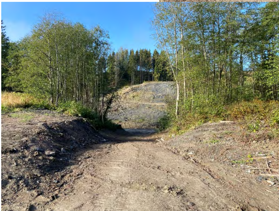
Figur 95: Driftsveien forsterket og etablert etter avtale med grunneier. Anleggsveien ned til Leirbekken ved P650 venstre side, står igjen pga. eventuelt fremtidig vedlikehold av sikringstiltaket i Leirbekken.
