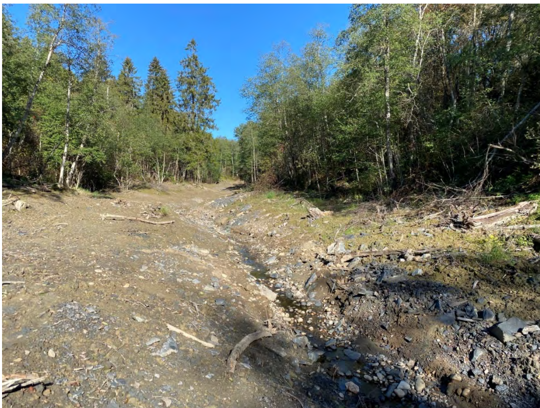
Figur 61: Bildet tatt fra ca. P540 og oppover bekken
