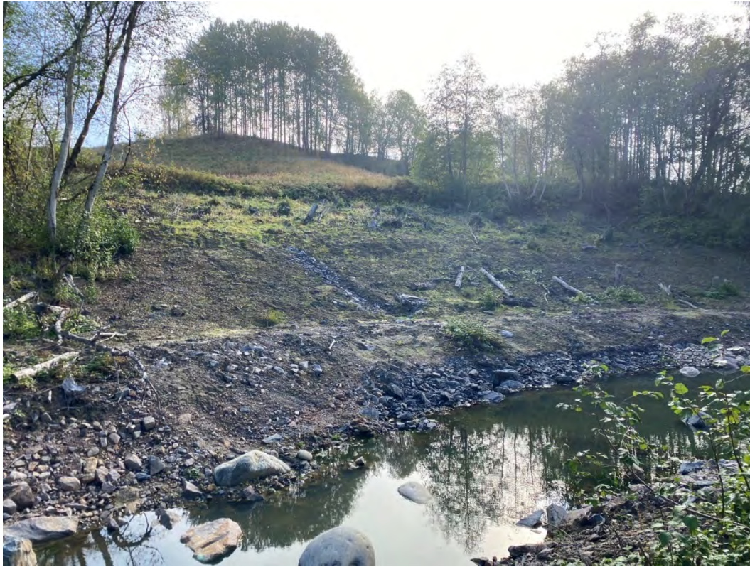
Figur 30: Bildet tatt fra ca. P515, støttefylling venstre side
