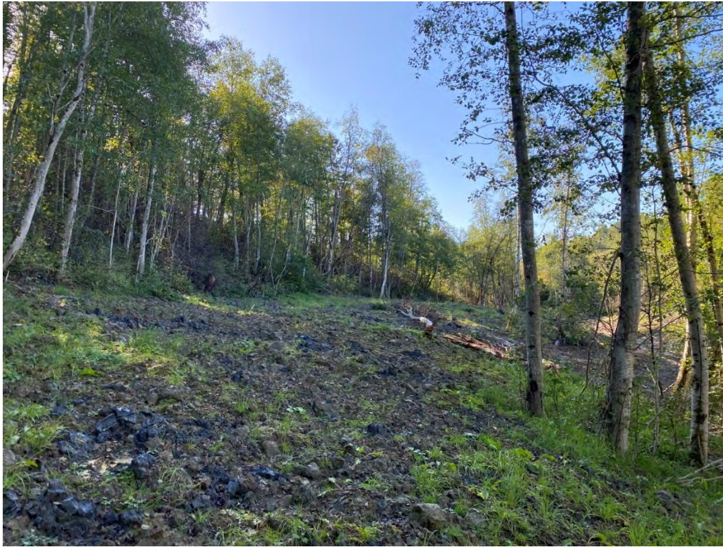
Figur 50: Støttefyllinga består av masser fra avlastninger. Bildet tatt fra ca. P1010 og nedover
