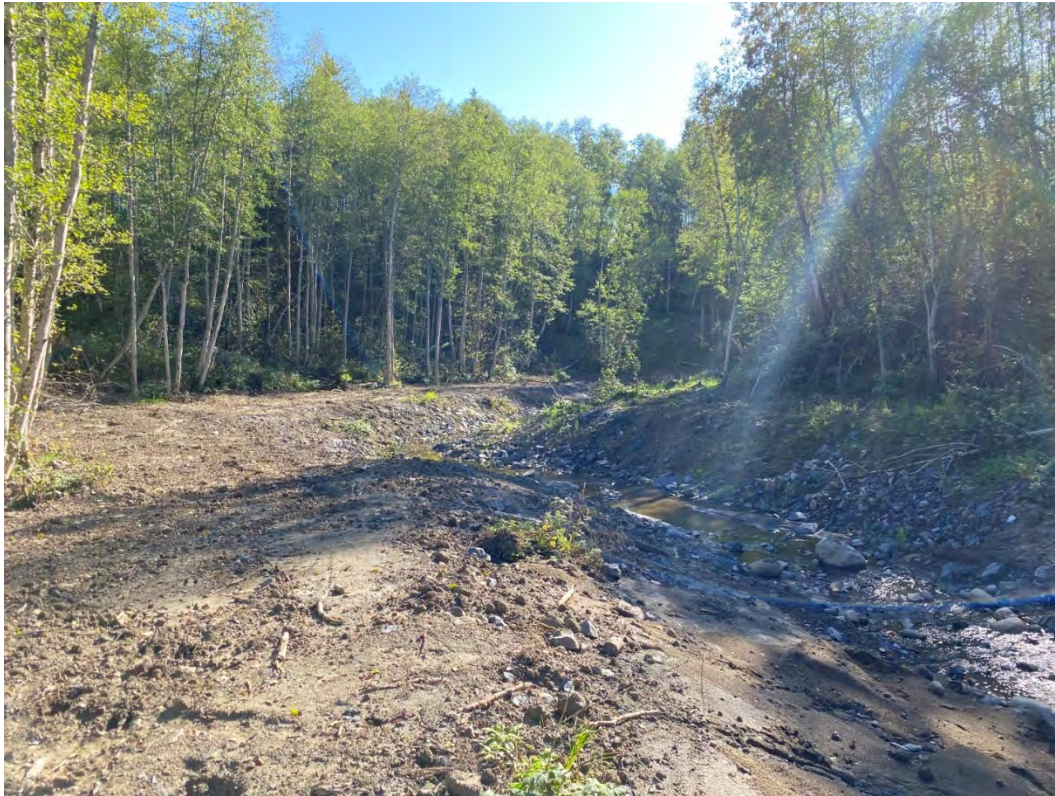
Figur 46: Bildet tatt fra ca. P930 og nedover bekken
