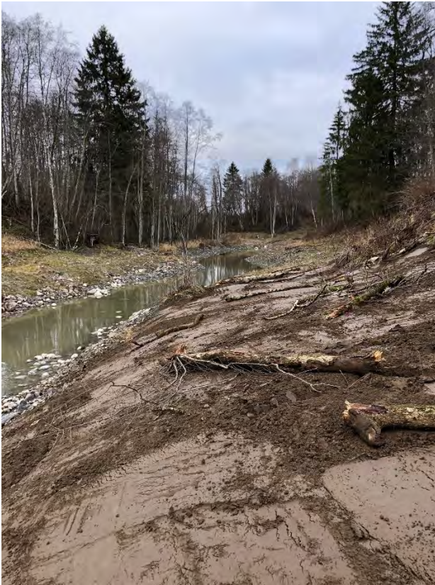
Figur 32: Bilde 17.11.2022. Ferdig miljøtiltak. Bildet er tatt fra P640 og oppover bekken.
