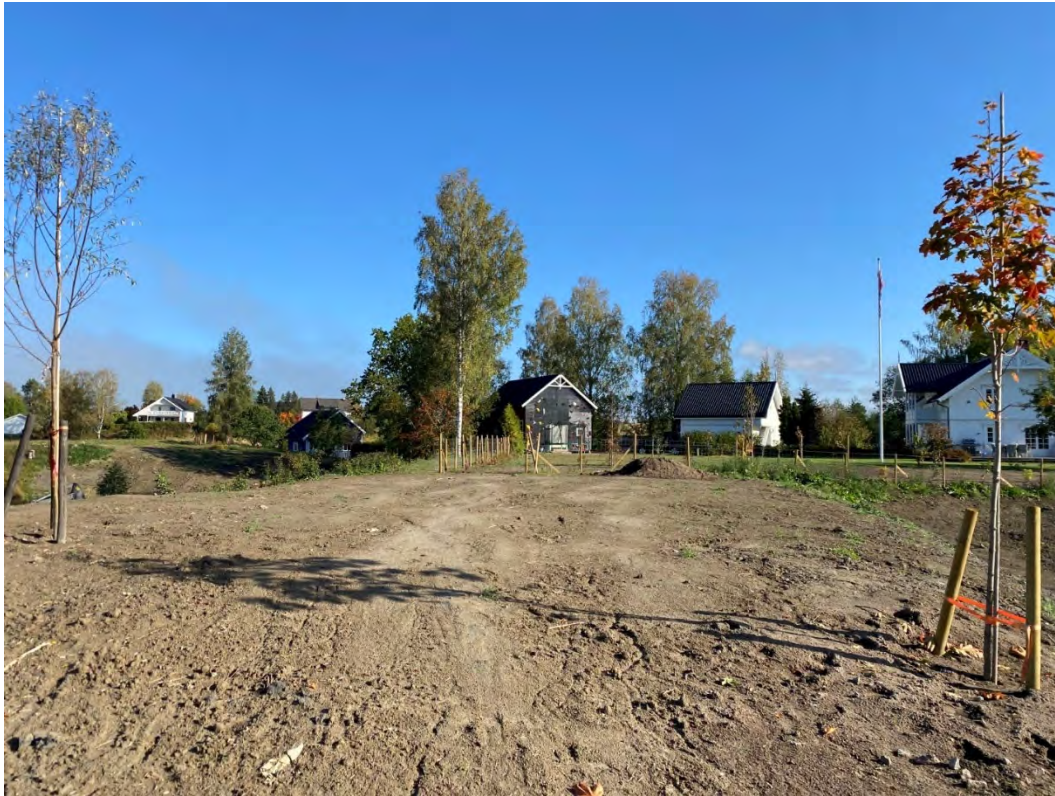
Figur 89: Avlastning ved Nv. 134 og Senepsrud gård. Gjerde satt opp.
