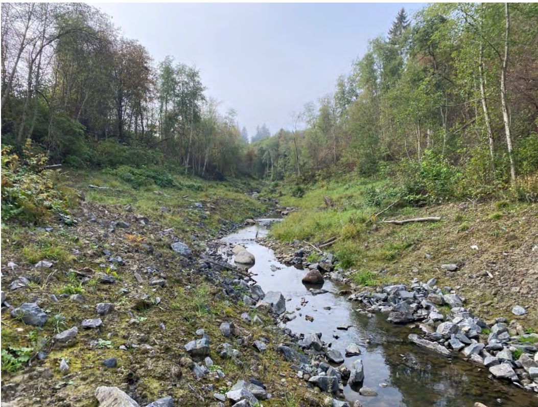
Figur 15: Bildet tatt fra ca. P150 og nedover bekken
