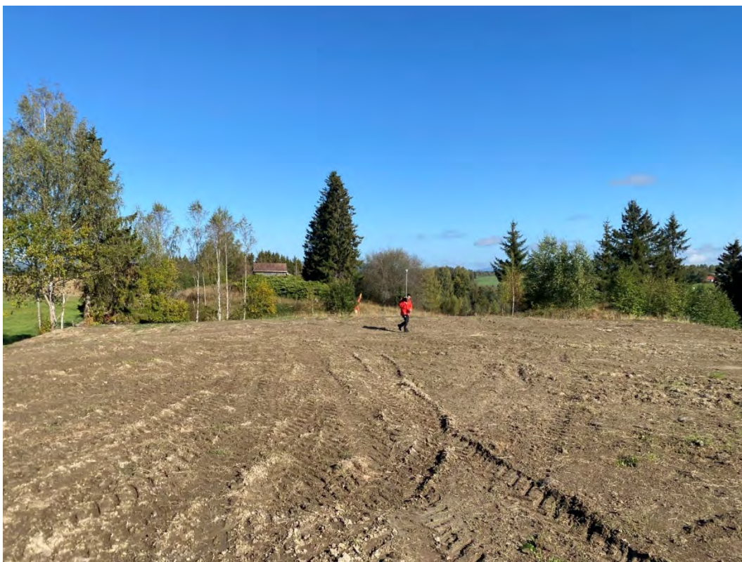
Figur 80: Avlastning vest. Bildet er tatt mot nord.
