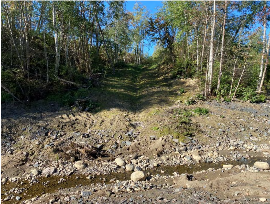
Figur 44: Sideravine venstre side ved P885 sikret helt opp
