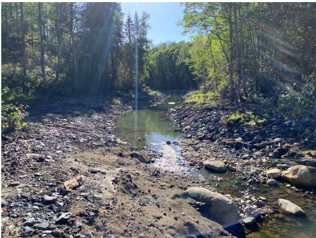
Figur 53: Bildet tatt fra ca. P1190 og nedover bekken. Steinterskel til høyre i bildet
