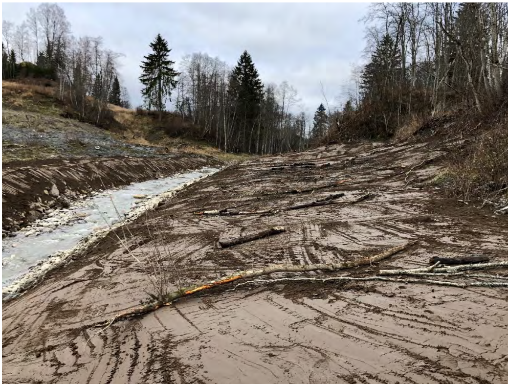
Figur 35: Bilde 17.11.2022. Ferdig miljøtiltak. Bildet er tatt fra P680 og oppover bekken
