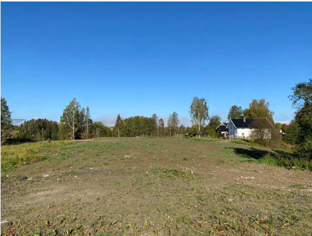
Figur 92: Avlastning ved Senepsrud gård. Bildet er tatt mot nord.
