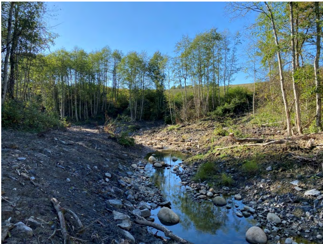
Figur 51: Bildet tatt fra ca. P1050 og nedover bekken
