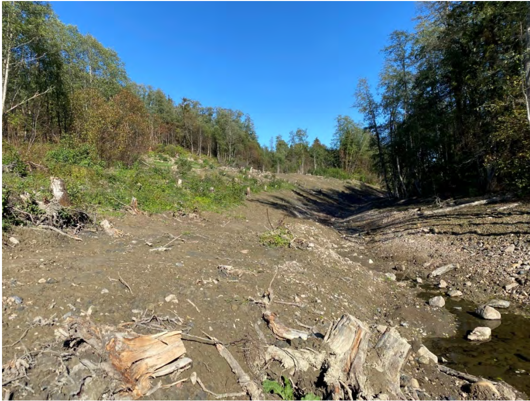
Figur 70: Bildet tatt fra ca. P110 oppover bekken. Viser støttefylling høyre side, masser fra avlastning.
