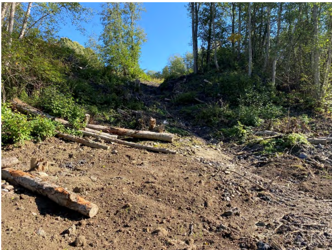
Figur 45: Sideravine høyre side ved P915 sikret helt opp
