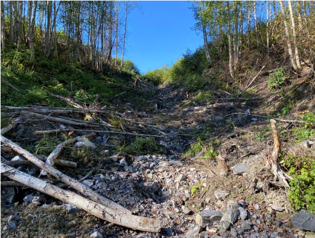
Figur 54: Sideravine høyre side ved P1230. Ravine sikret helt opp
