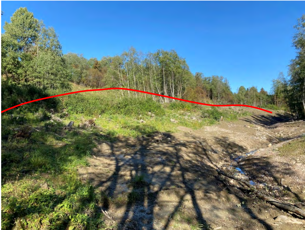
Figur 68: Bildet tatt fra ca. P210 og oppover bekken. Stor støttefylling (rød strek) langs høyre side av bekken.
