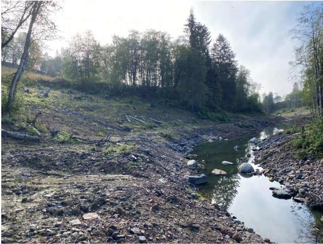
Figur 28: Bildet tatt fra ca. P500 og nedover bekken
