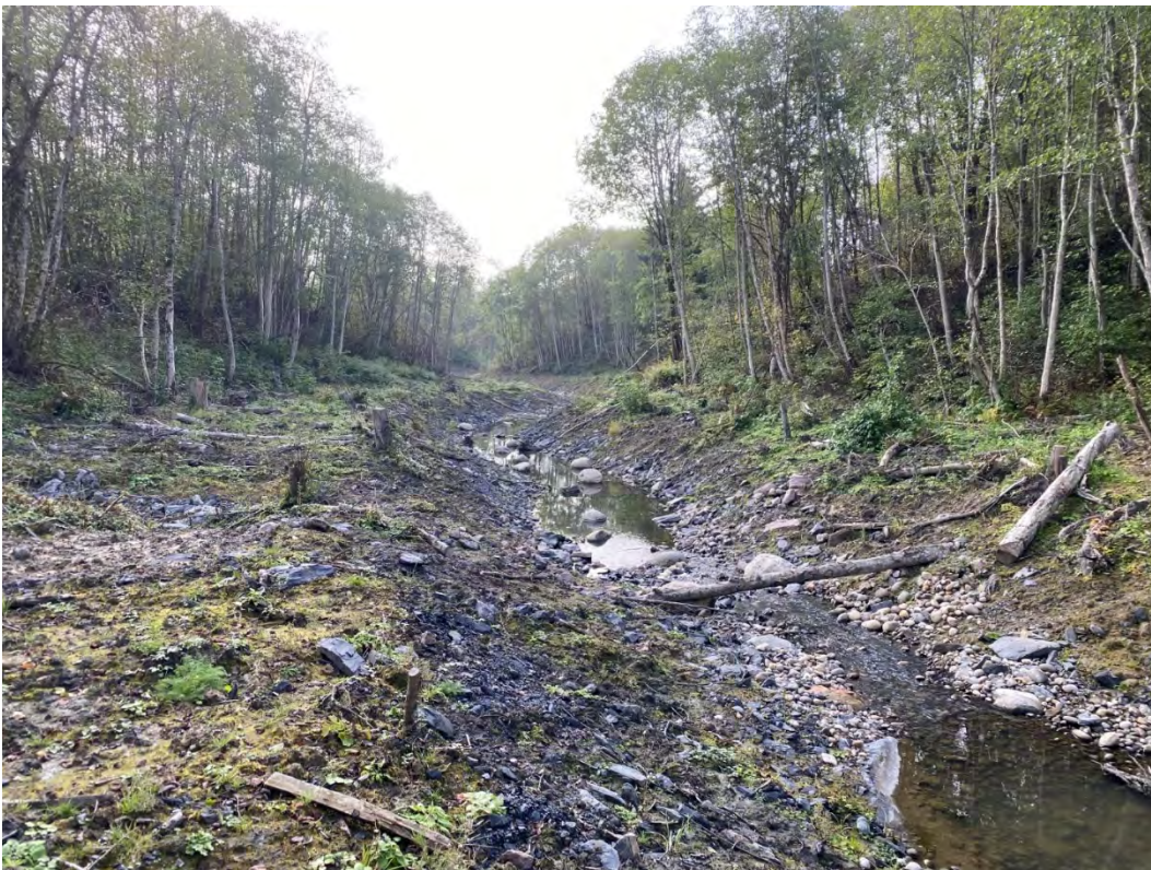
Figur 21: Bildet tatt fra ca. P300 og nedover bekken
