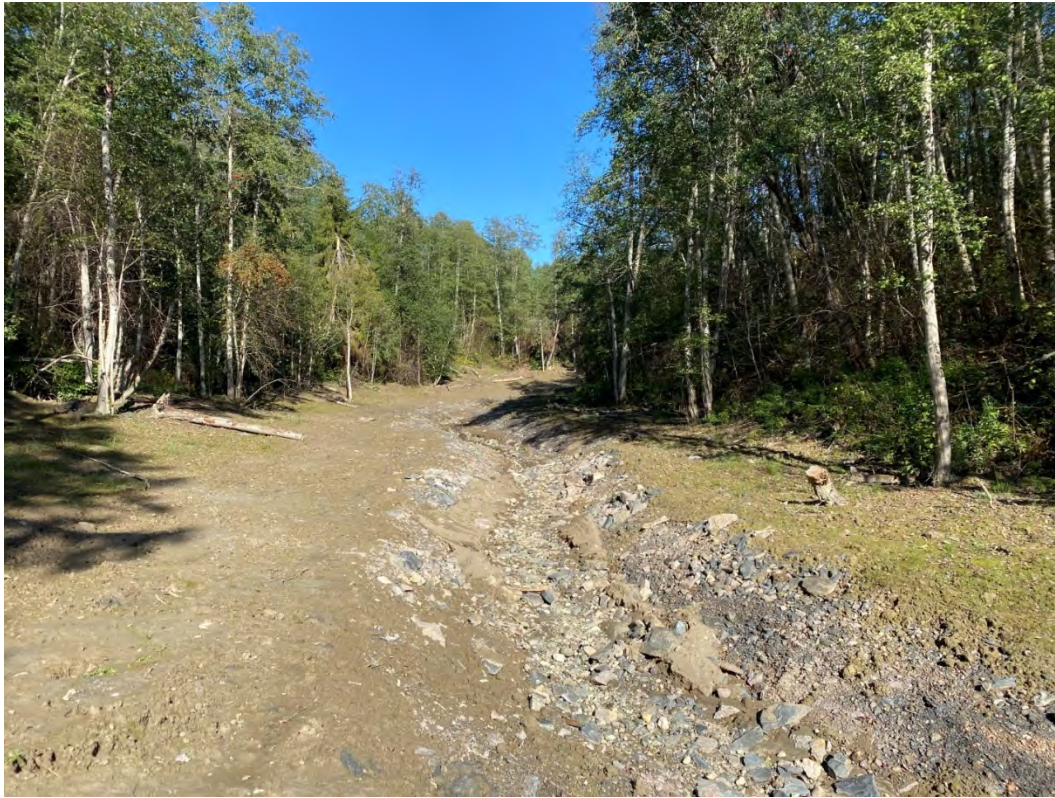
Figur 64: Bildet tatt fra ca. P440 og oppover bekken
