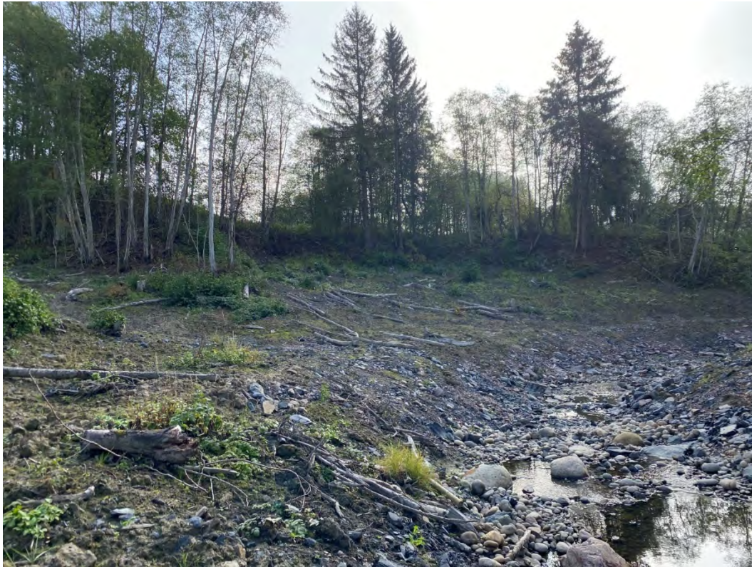
Figur 24. Bildet tatt ca. fra P400. Viser støttefylling venstre side
