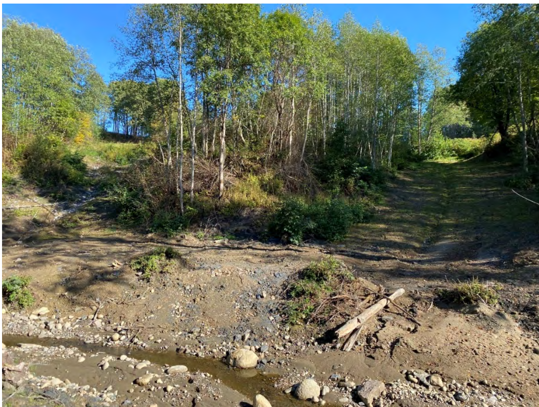
Figur 43: To sideraviner venstre side ved P845 sikret helt opp
