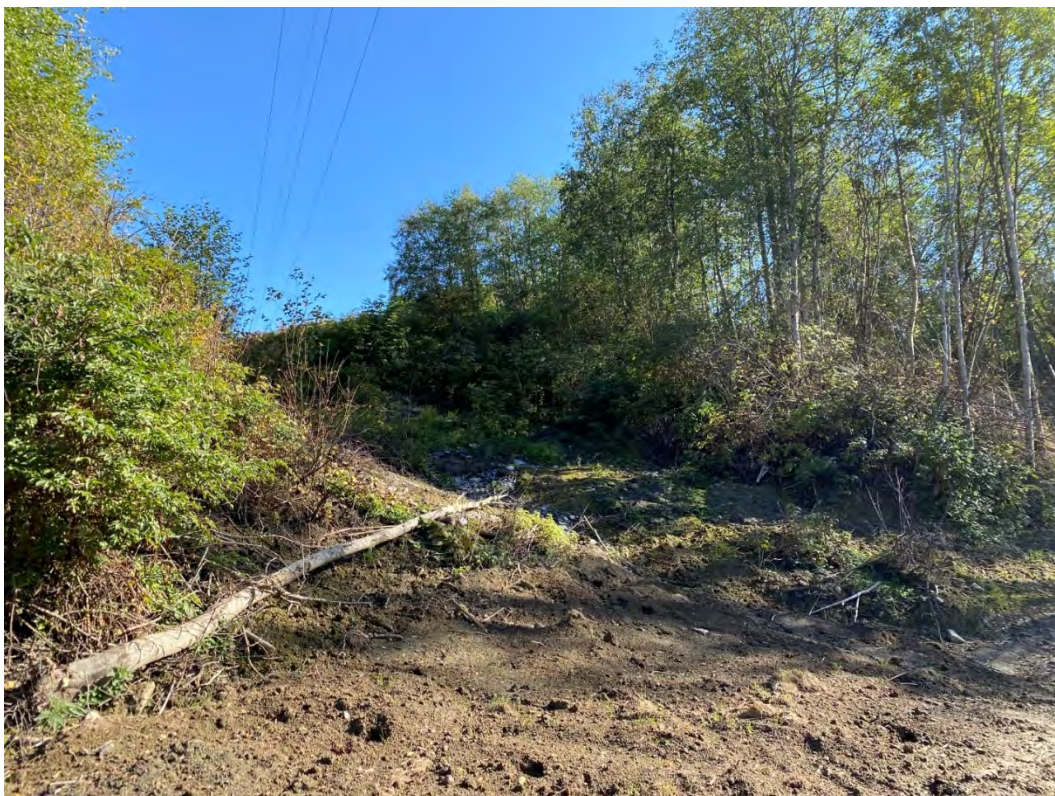
Figur 41: Sideravine venstre side ved P825 sikret helt opp
