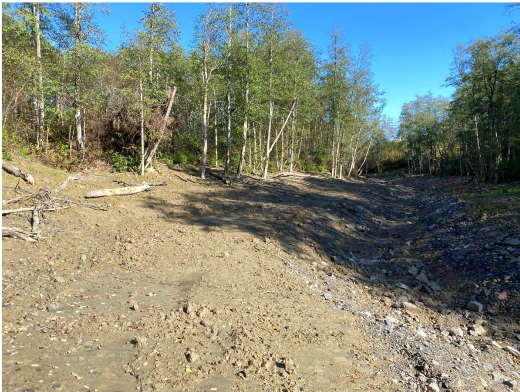
Figur 65: Bildet tatt fra ca. P360 og oppover bekken
