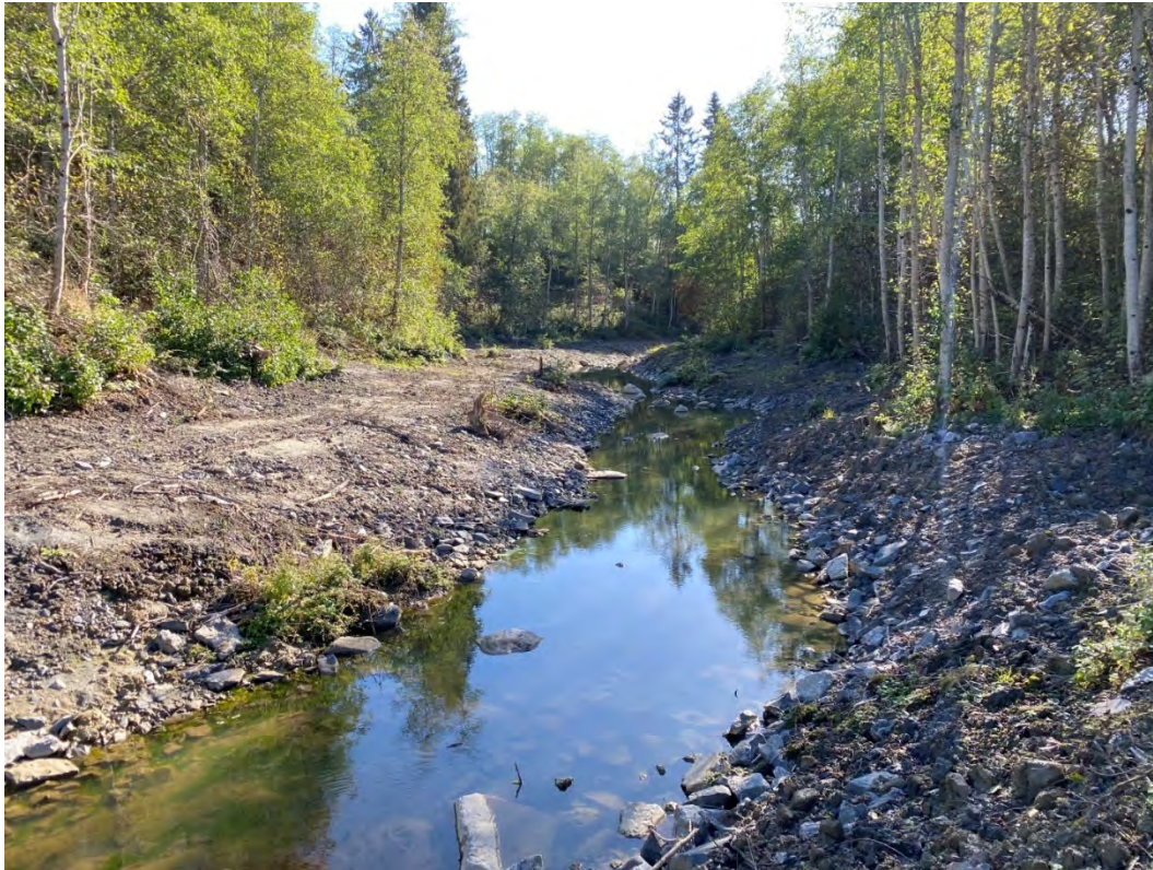
Figur 52: Bildet tatt fra ca. P1100 og nedover bekken. Stille vann pga. terskel lengre nedstrøms
