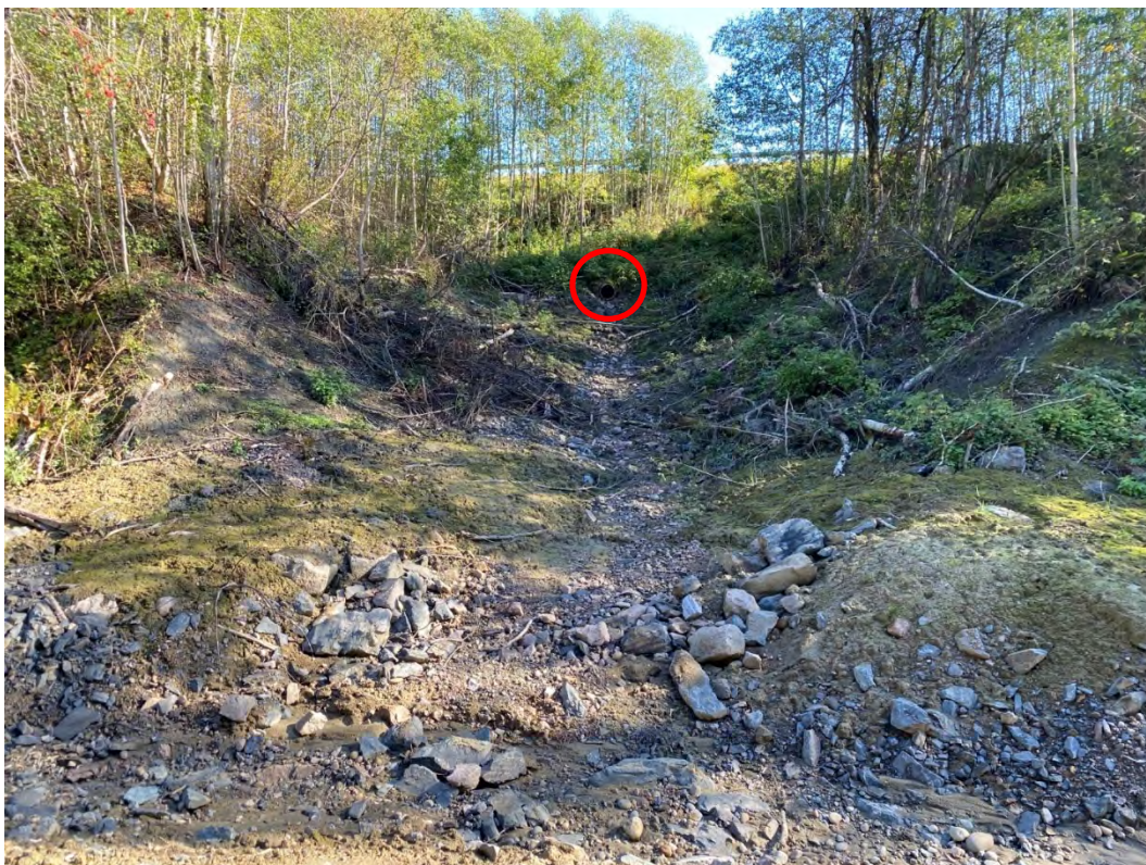
Figur 63: Sideravine venstre side ved P450. Sikret helt opp til utløp rør (rød sirkel) under Fv. 120.
