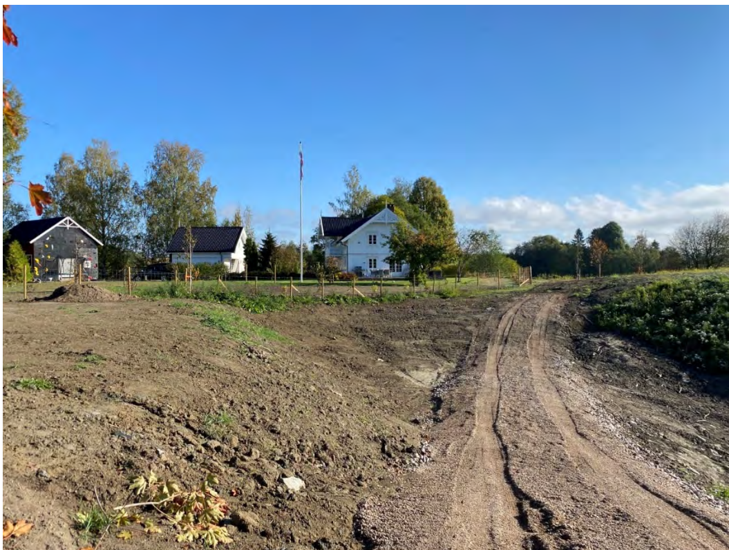
Figur 90: Driftsveg etablert og ravine ved Senepsrud gård sikret. Drenerende masser og rør er lagt for å håndtere overvann
