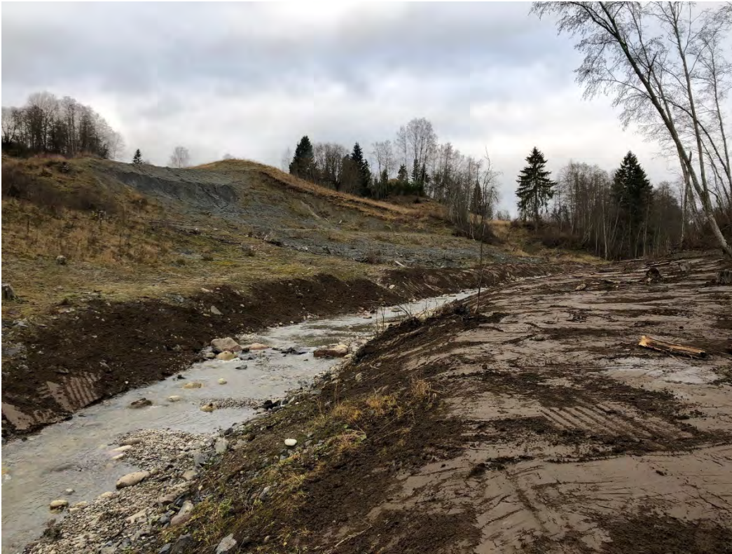
Figur 38: Bilde 17.11.2022. Ferdig miljøtiltak. Bildet er tatt fra P720 og oppover bekken
