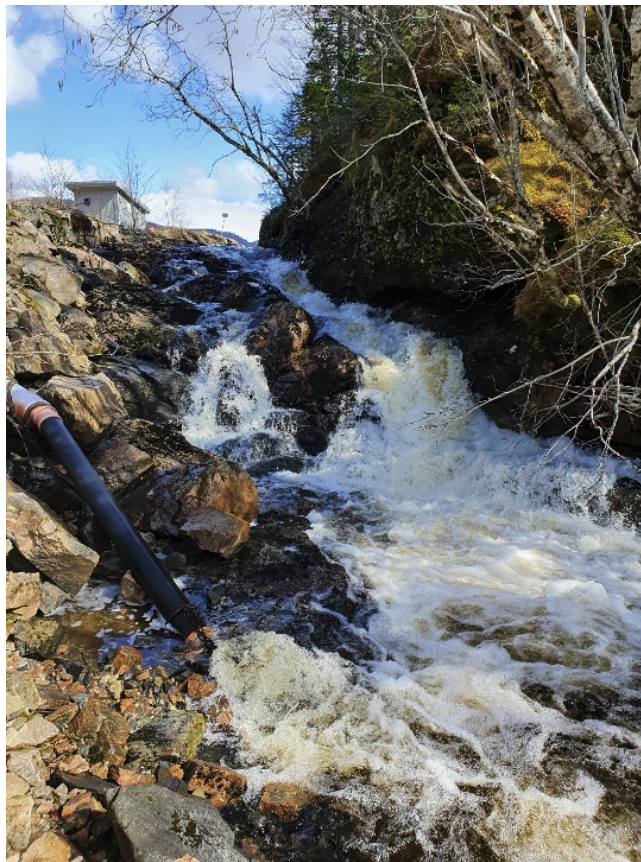
Figur 12: Utslipp av minstevannføring nedstrøms demning Ausvatnet ved middels vannstand.
