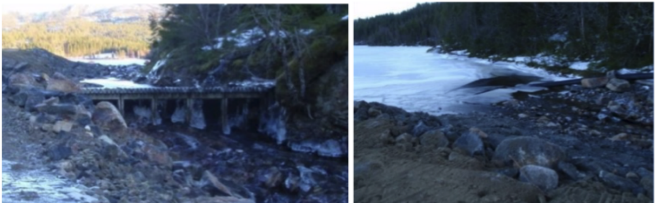
Figur 6: Bilde til venstre viser fiskesperra som ble fjernet i 2012. Bilde til høyre viser utløpet av Ausvatnet før bygging av demning.
