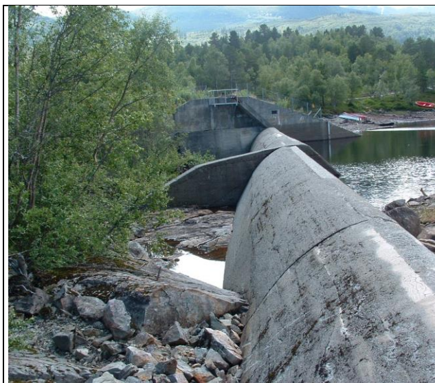
Flomløpet mot vangemuren.
