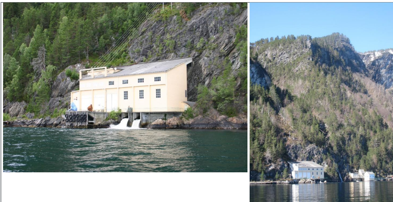
Figur 12. til venstre: eksisterende Fausa kraftverk; til høyre Fausa og Fausa III kraftverk.
