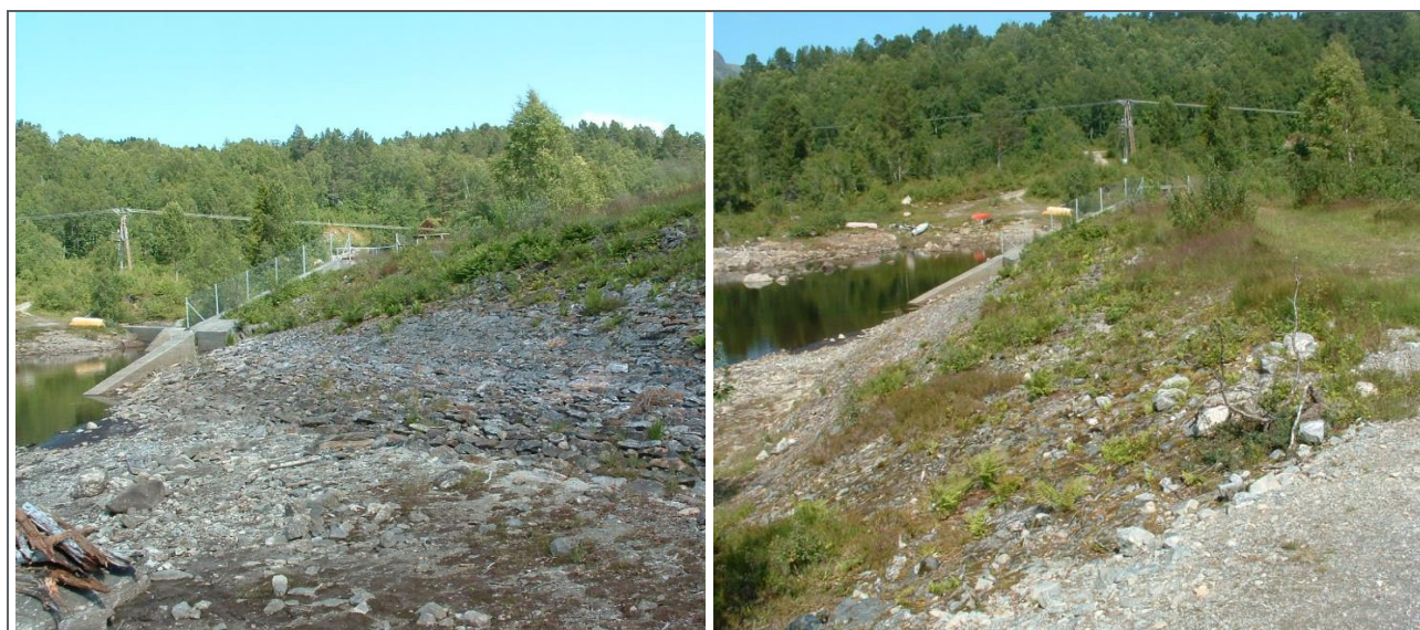
Jordfyllingsdam, oppstrøms side
