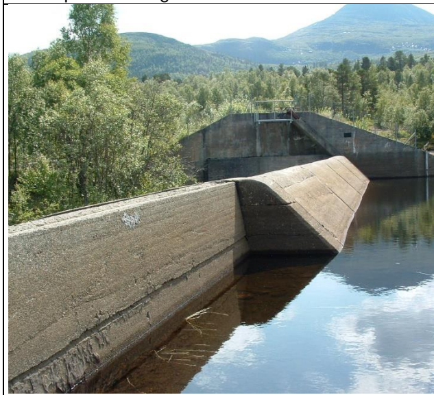
Flomløpet på vannsiden.
