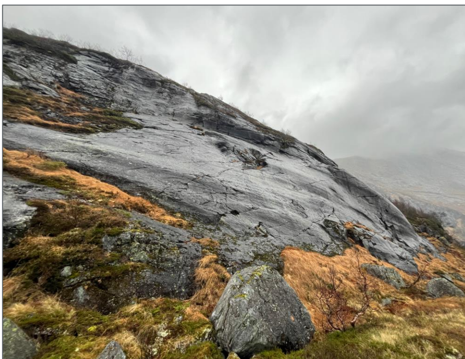
Figur 60 Bratt bergskrent hvor det er planlagt påhugg helt øst i kartleggingsområdet ved Tyssevatnet, ved infopunkt 18. Bilde tatt mot nord.
