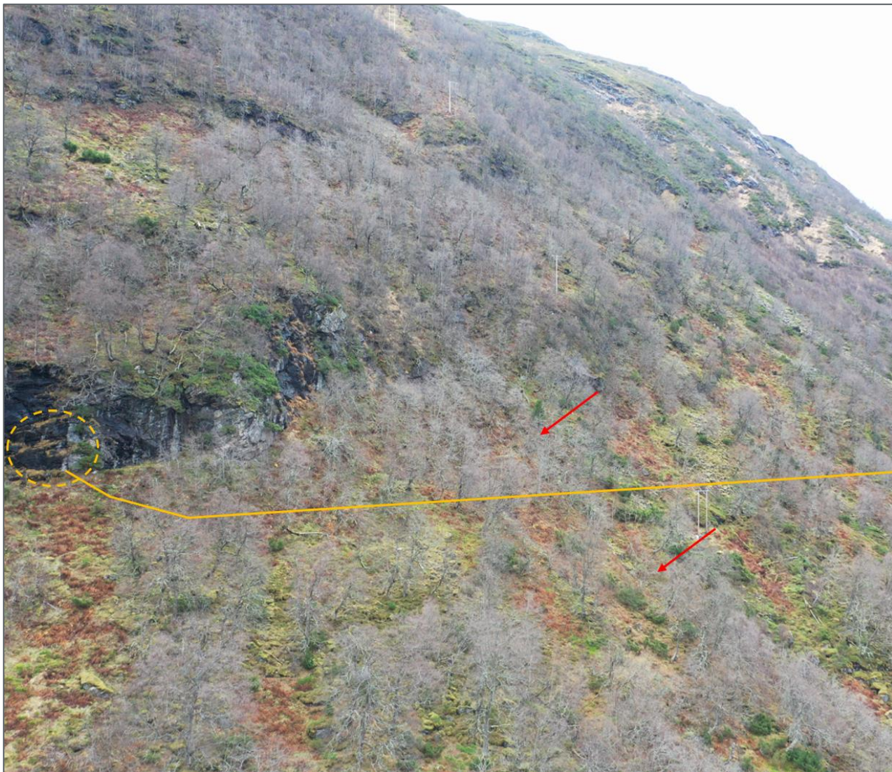
Figur 45 Røde piler viser spor etter tidligere flomskred, eventuelt vått snøskred eller sørpeskred med mye vann, som er observert i skyggerelieff. Ca. plassering av mulig påhuggsområde for tunnel vises med oransje stiplet sirkel og planlagt vegtrase med oransje linje. Bilde tatt mot sørøst.
