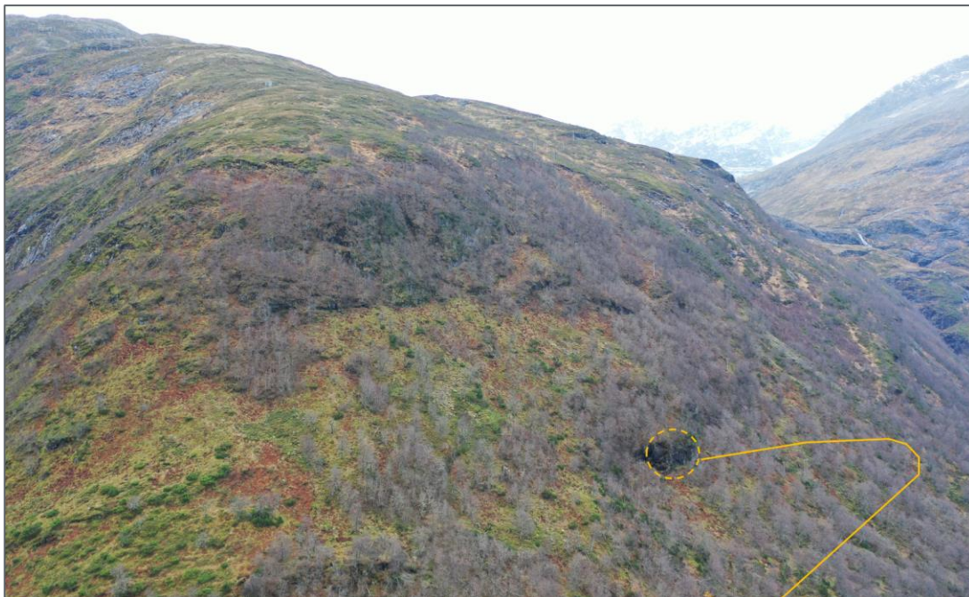
Figur 42 Dronebilde av fjellsiden. Ca. plassering av mulig påhuggsområde for tunnel vises med oransje stiplet sirkel og planlagt vegtrase med oransje linje. Bilde tatt mot sør/sørøst.
