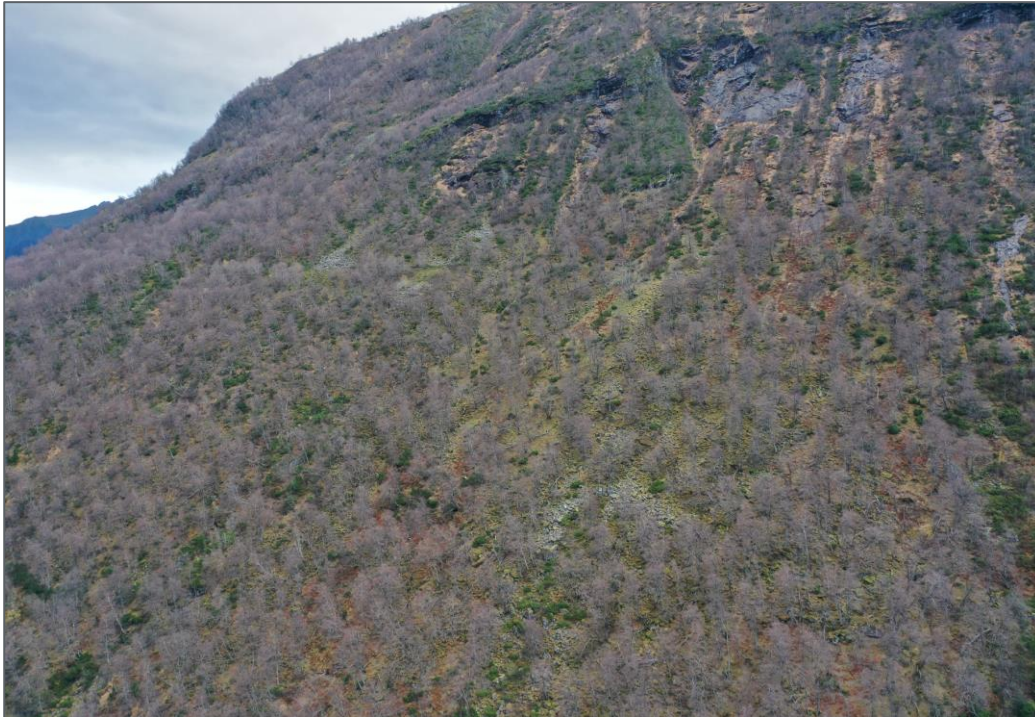
Figur 34 Dronebilde av nedre og midtre deler av fjellsiden. Løsneområder for steinsprang ses øverst i bildet. Det er stedvis lite vegetasjon som tyder på at området er aktivt og at det går skred jevnlig. Bilde tatt mot vest.
