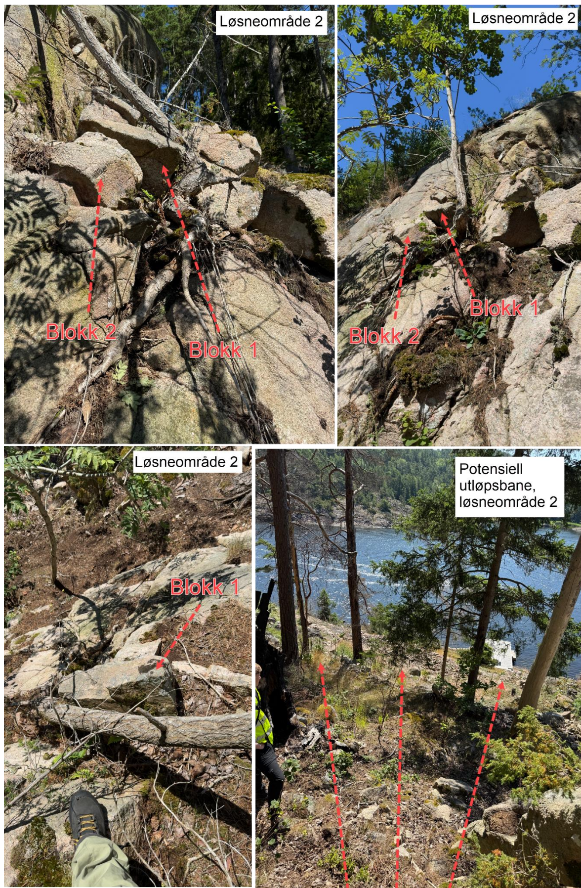
Figur 4-2: Løsneområde 2. Med potensiell utløpsbane. Løsnensannsynligheten vurderes til å være lavere enn 1/1000.
