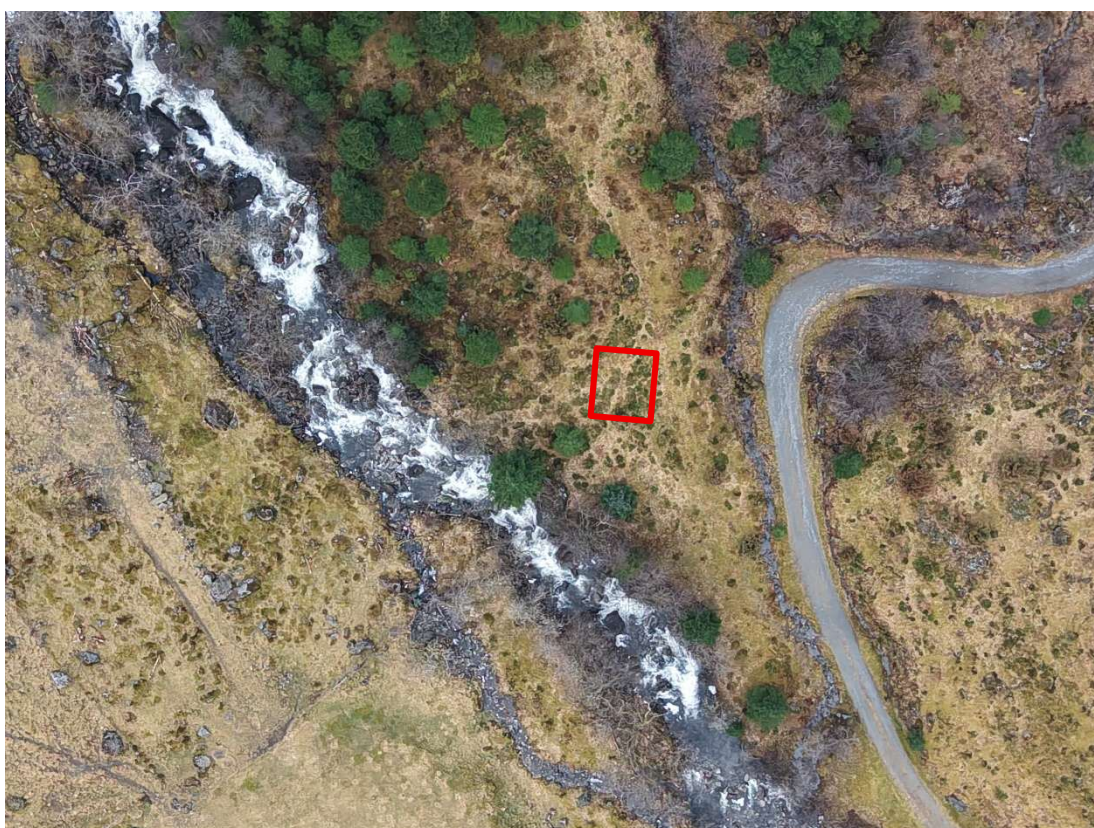
Bilde 9, dronefoto av kraftstasjonsområde. Kraftstasjonsplassering er angitt med rød firkant
