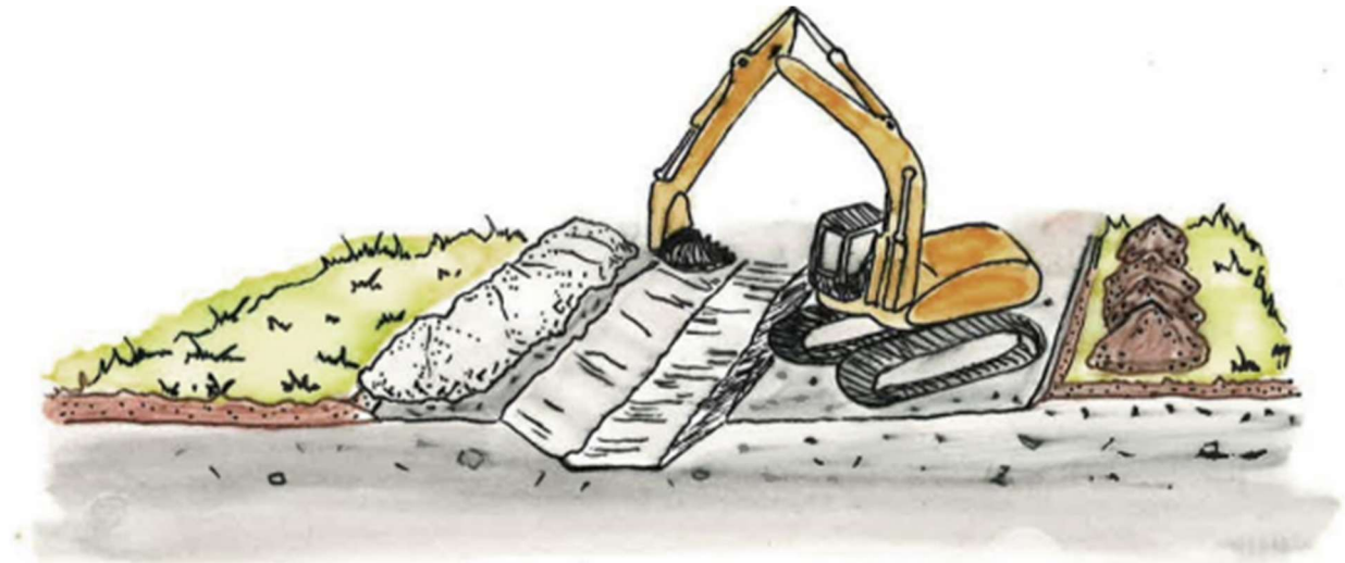
Figur 8, prinsipp for avdekking og mellomlagring av vekstmasser og undergrunnsmasser langs vei og grøft i flatt terreng. Her er massene (vekstmasser og undergrunnsmasser) sortert og lagt på hver sin side av inngrepet. Brune masser til høyre er vekstmasser, mens hvite masser til venstre er undergrunnsmasser.
