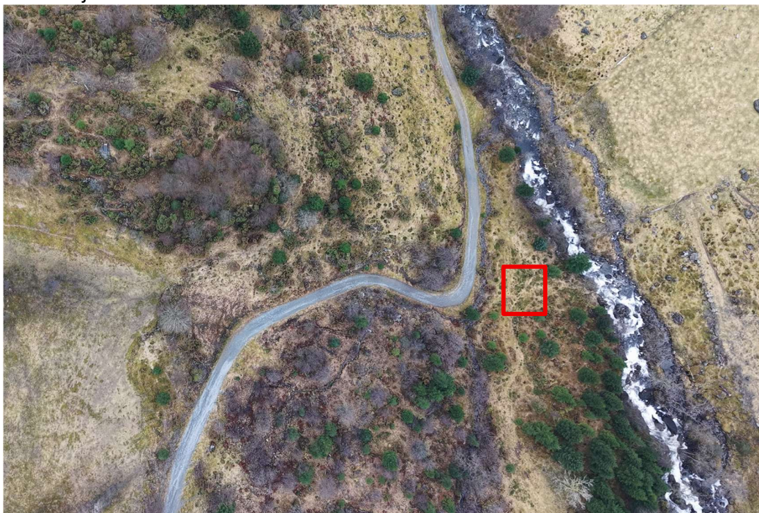
Bilde 8, dronefoto av kraftstasjonsområde. Kraftstasjonsplassering er angitt med rød firkant
