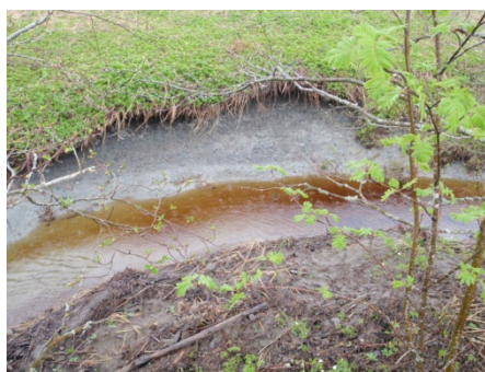
Bilde 2.6 Små overflateutglidninger i bekken nærmere sjøen med leire i dagen.
