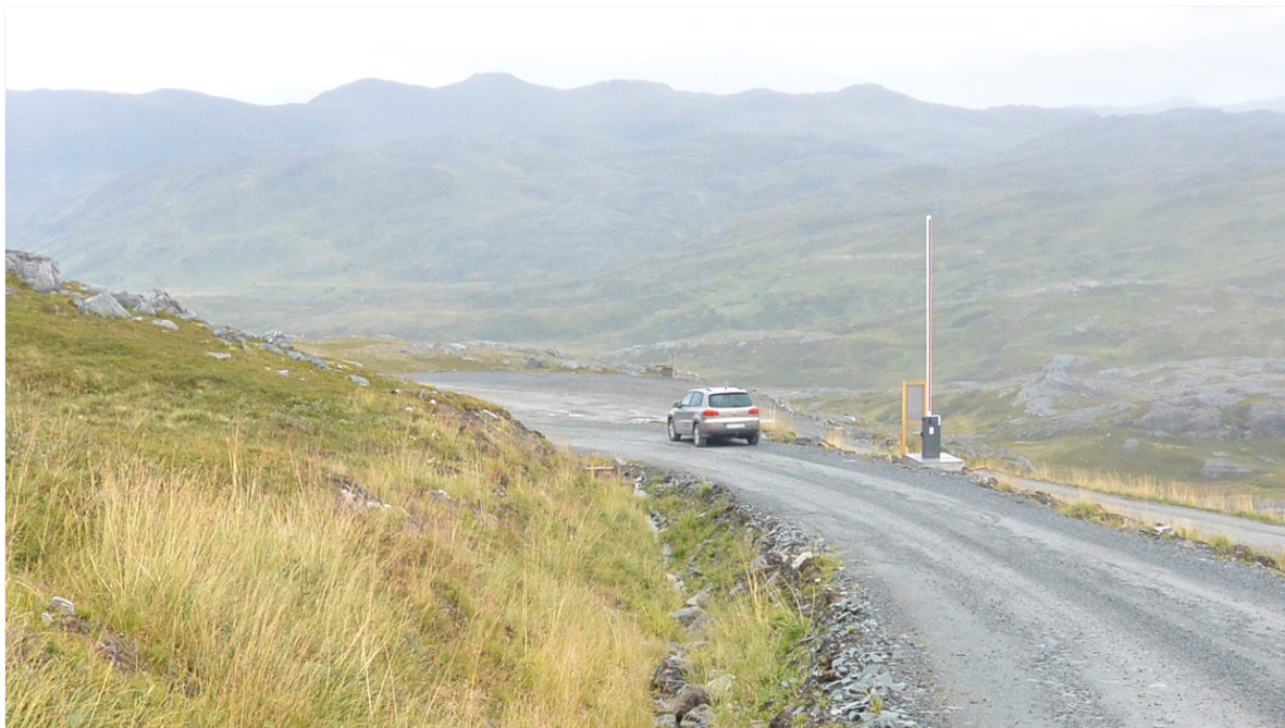
Figur 1. Bilde av bommen inn til vindkraftverket sett fra anleggsveien ned mot veien mellom Breivikbotn og Dønnesfjordbotn. Kilde: Multiconsult.
