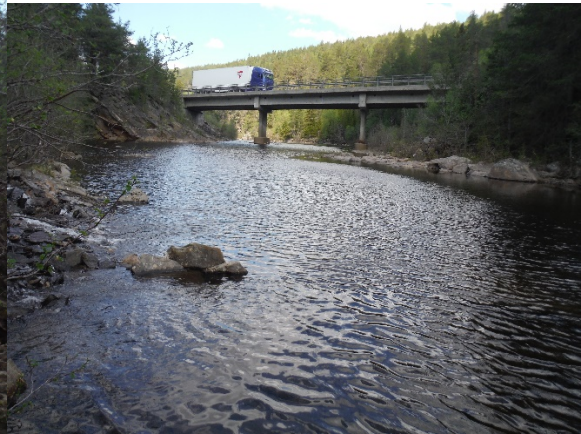
Vannspeil nr. 3 (sett medstrøms)
