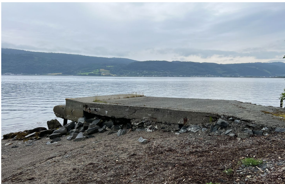
Figur 7: Eksisterende lossehakk ved "Surna kai".
