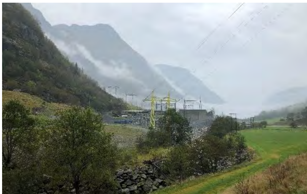
Figur 3-24: Kraftstasjonen i Mauranger utsyn vestover fra munningen av Folgefonntunnelen
