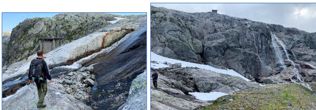
Figur 2-8. Bekk ved lukehus. Til høyre: lukehus og bekk mot horisonten fra eksisterende tipp.
