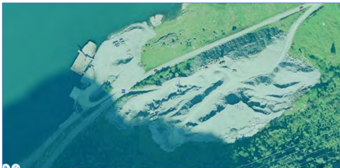
Figur 2-20. Flyfoto fra perioden 2003-2013, viser at steinmasser fra Folgefonn-tunnelen ble deponert her, sortert, og fraktet vekk. Steinlekter ligger ved kai på bildet (2003).
