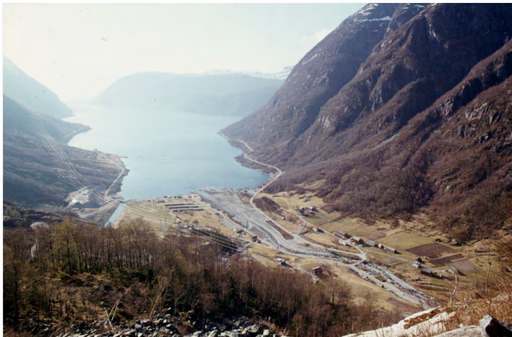
Figur 3-26 Austrepollen 1974. Her ser en hvordan elveviften har blitt samlet i et kunstig løp, og utløpstunnelen er blitt anlagt til venstre (sør for gården Gjerde). Fotograf: Knut Ove Hillestad/NVE.
