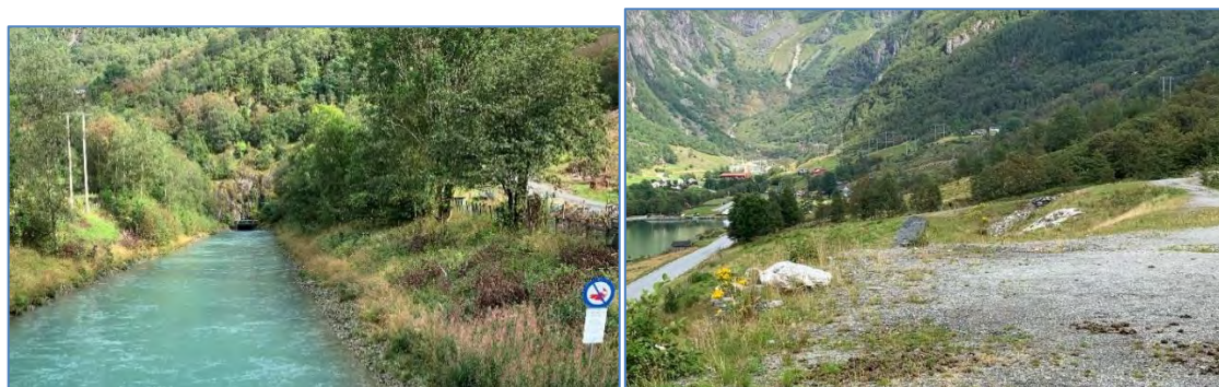
Figur 2-19. Til venstre: Utløpskanal Mauranger kraftverk. Til høyre: Alternativ tipp ved kai.
