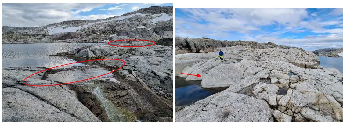
Figur 2-12. Til venstre: betongterskler. Til høyre: lokalisering av grøft/kanal.
