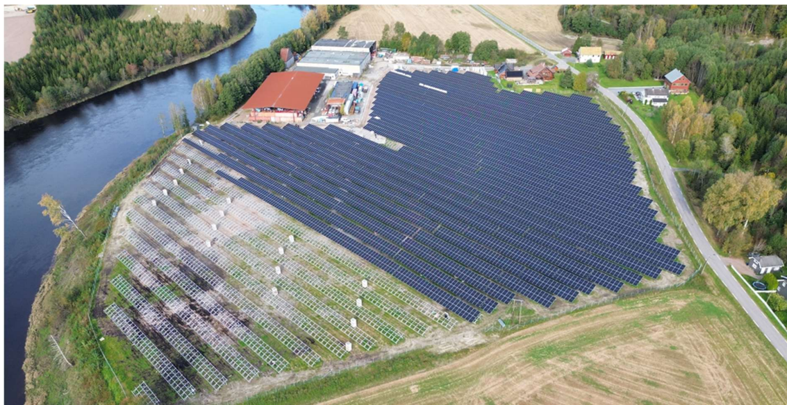
Figur 2. Engene solkraftverk under bygging – på en nedlagt industritomt på Hvarnes i Larvik
