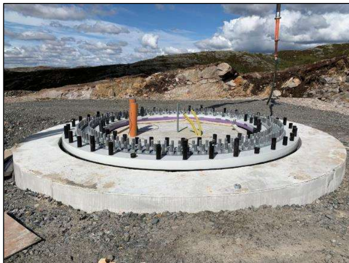
Figur 3-2: Turbinfundament og tårn i Tonstad vindkraftverk etter tilbakefylling av masse. Mest sannsynlig vil det bli valgt samme type fundamentering på Aremark. (Foto: Tonstad Vindpark AS)
