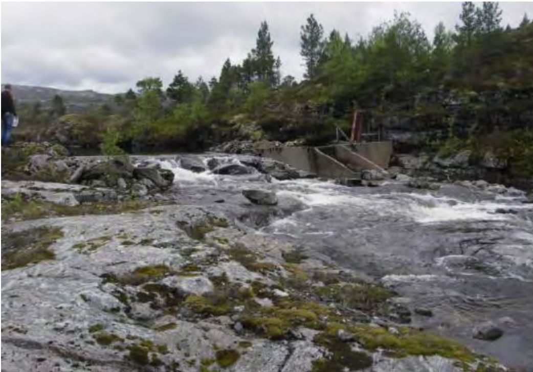
Figur 11 Dam Grovlivann, overløp over betongterskel med steinfylling nedstrøms
