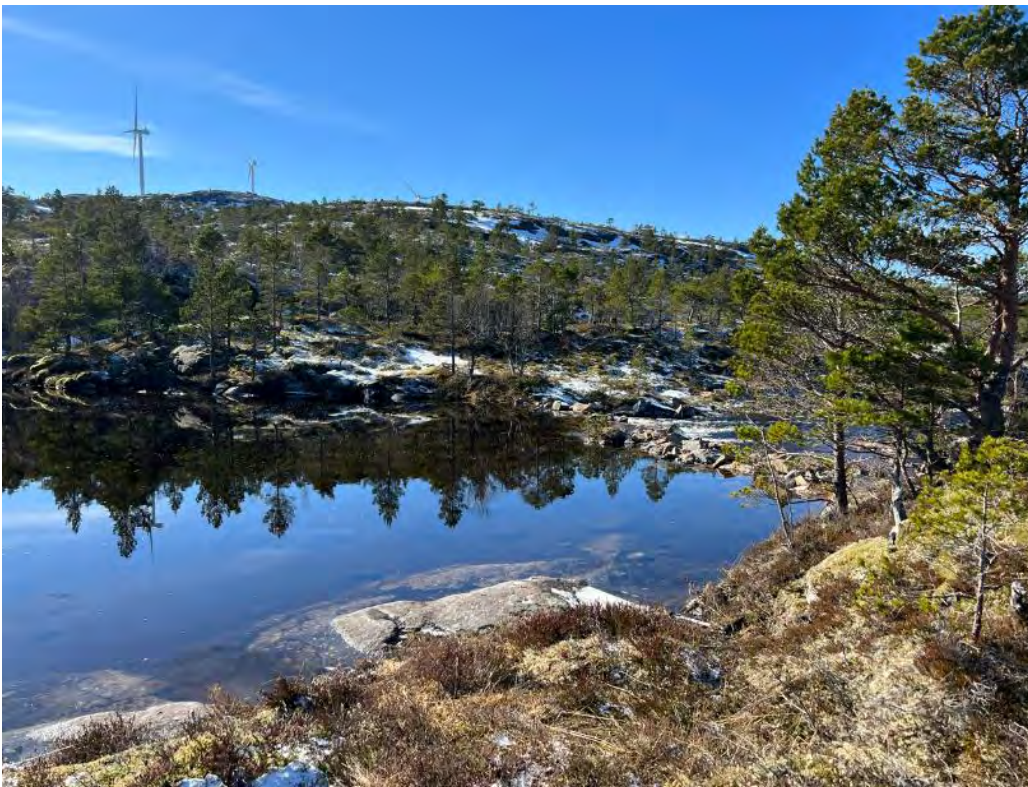
Figur 5 Rester av eldre steinfyllingsdam
