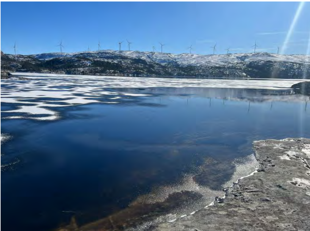
Figur 12 Grovlivannet, sett fra Dam Grovlivann
