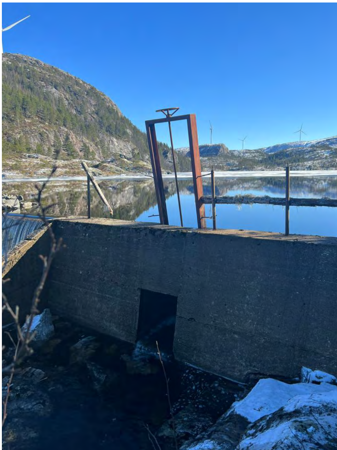
Figur 10 Eksisterende dam og bunntappeluks
