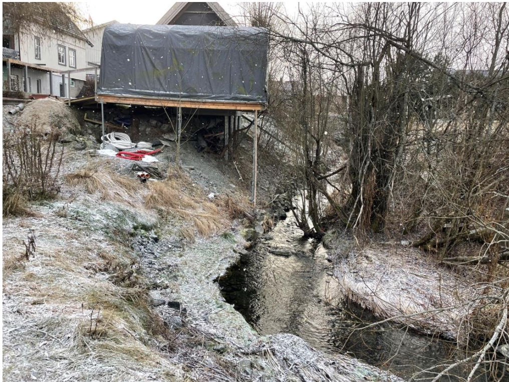
Figur 9: Bekk mellom sone Fabrikkgata og Vestfossen idrettspark. Mulig tegn til erosjonssikring på nedsiden av hus langs bekkekant. (lokasjon 1, Figur 8)
