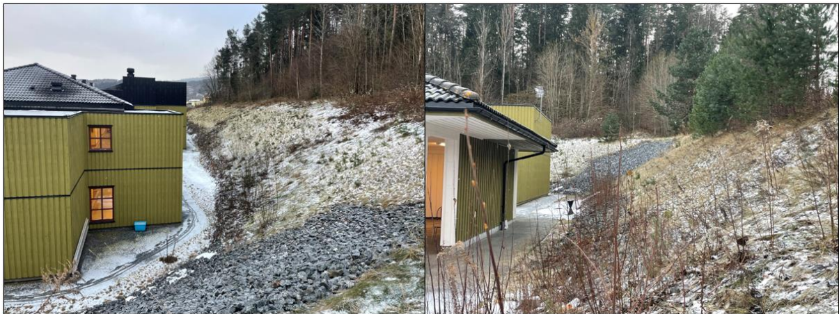
Figur 7: Terrenginngrep/grusfylling på sør/vestside av Villa Skaar (lokasjon 6, Figur 1)
