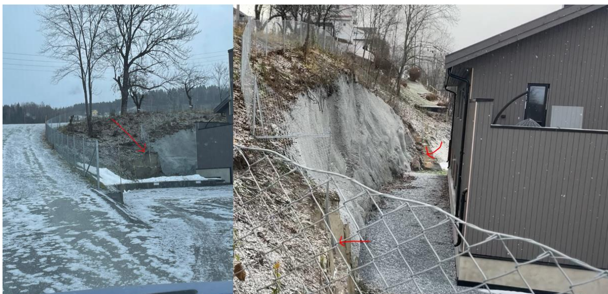
Figur 21: Fjellskjæring ved Arneberg, utenfor prosjektområde (lokasjon 8, Figur 8)
