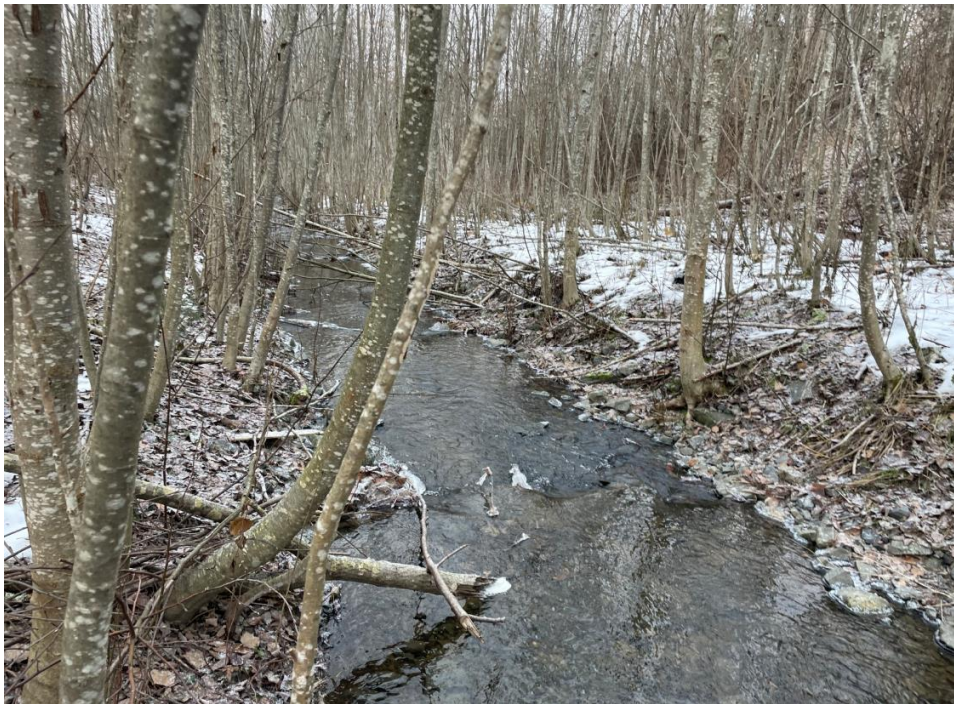
Figur 18: Sikret ravine mellom Sørenga og Vestfossen idrettspark. Lav terrenggradient og klart vann i bekk (lokasjon 5, Figur 8)
