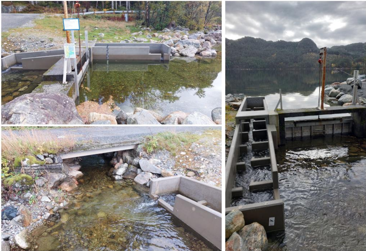
Figur 10. Bilete frå damanlegget og fisketrappa (Bilete: Norconsult, 2022)
