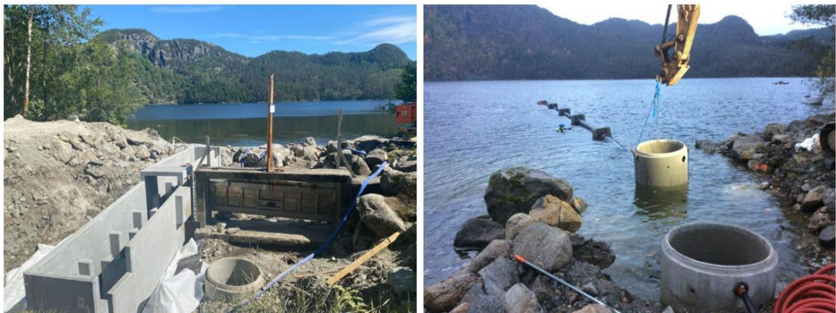
Figur 9. Bilete av arbeid med installering av fisketrapp i Fisteråna i (Stangeland maskin, 2023)
