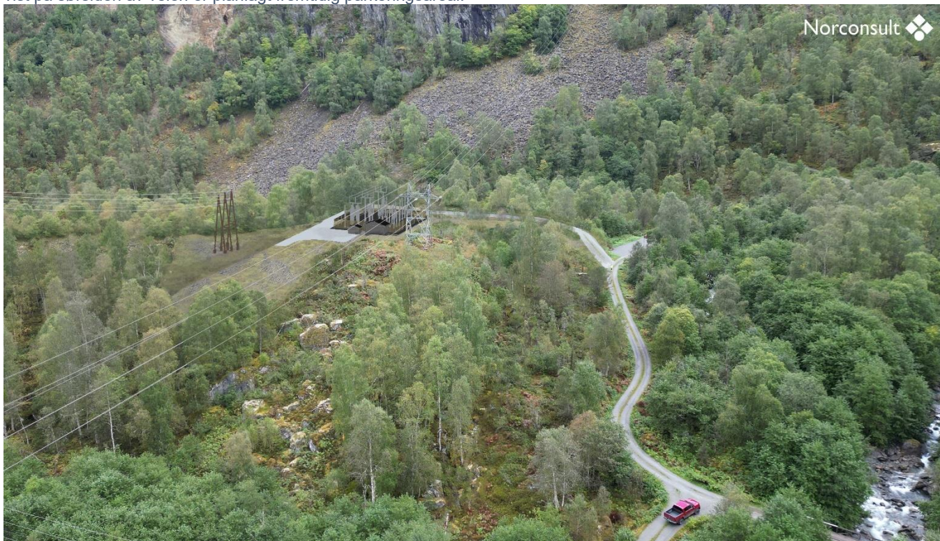
Figur 4-4: Fotovisualisering av Sveinsøystølen. Merk at det vil komme ensidig kabelstativ ved mast til venstre i bildet, og dobbeltsidig kabelstativ ved gittermast til høyre i bildet (Herva linjen). Mast til venstre er visualisert som brun-eloksert, Hydro søker primært om at masten skal være ikke-eloksert og med naturlig aluminiumfarge. Parkeringen til Ormeli kan sees øverst i bildet i enden av veien.
