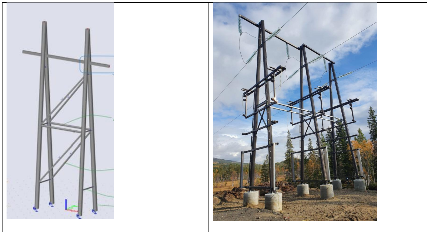
Figur 5-3 Aluminiumsmastene som er planlagt benyttet. Fra venstre mot høyre A-mast med indre bardun og 3A-mast med kabelstativ klar for kabelnedføringer. Foto: Lena metall AS.
