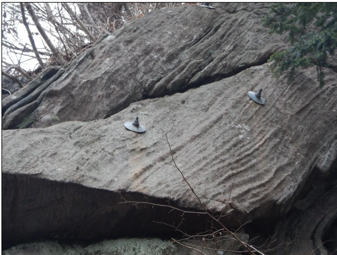
Figur 6: Eksempel på boltenes tilfredsstillende tilstand på synfaringstidspunktet.
