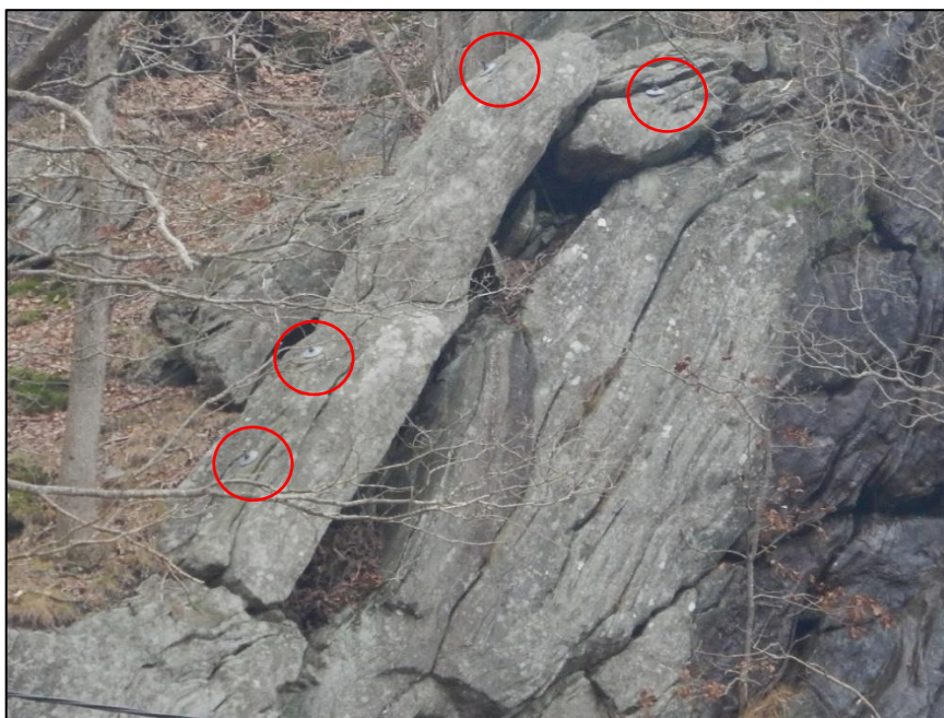
Figur 3: Eksempel på blokker som er konservativt bolta og har en løsesannsynlighet lavere enn 1/1000. Blokkene i denne figuren kan også ses øverst til høyre i Figur 4.
